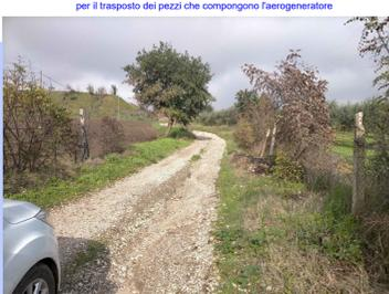
FOTO 71 - Caviddotto MT di progetto su strada bianca esistente. Adeguamenti stradali per garantire i parametri minimi previsti per il trasporto dei pezzi che compongono l'aerogeneratore
