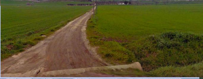
FOTO 68 - Caviddotto MT di progetto su strada bianca esistente. Adeguamenti stradali per garantire i parametri minimi previsti per il trasporto dei pezzi che compongono l'aerogeneratore
