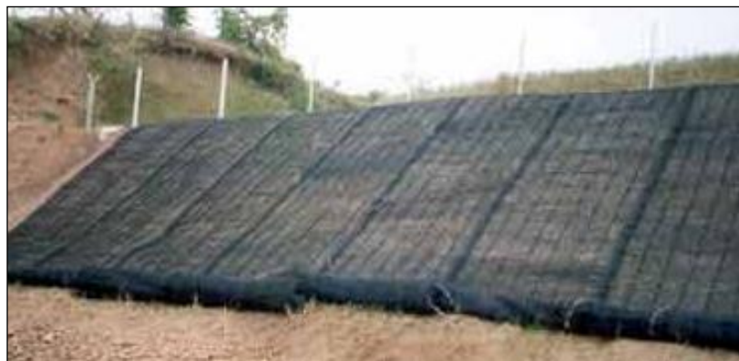
Figura 36: Bobine di geostuoia poste in opera su un versante stradale.
