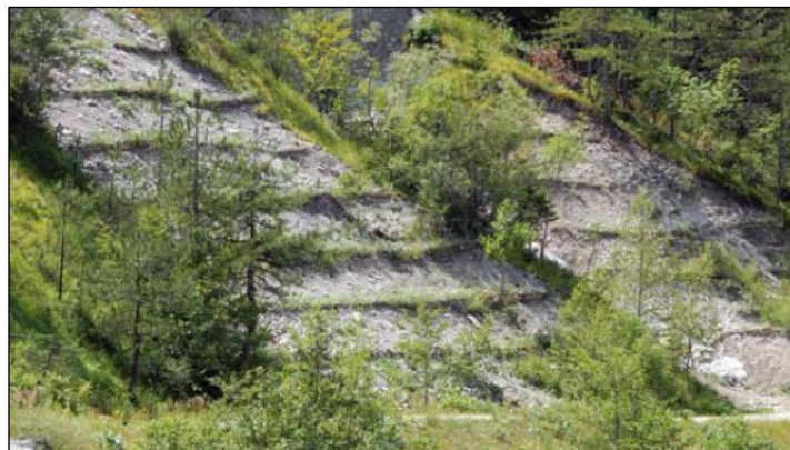
Figura 34: Particolare della gradonata viva all'inizio della prima stagione vegetativa (post-operam).
