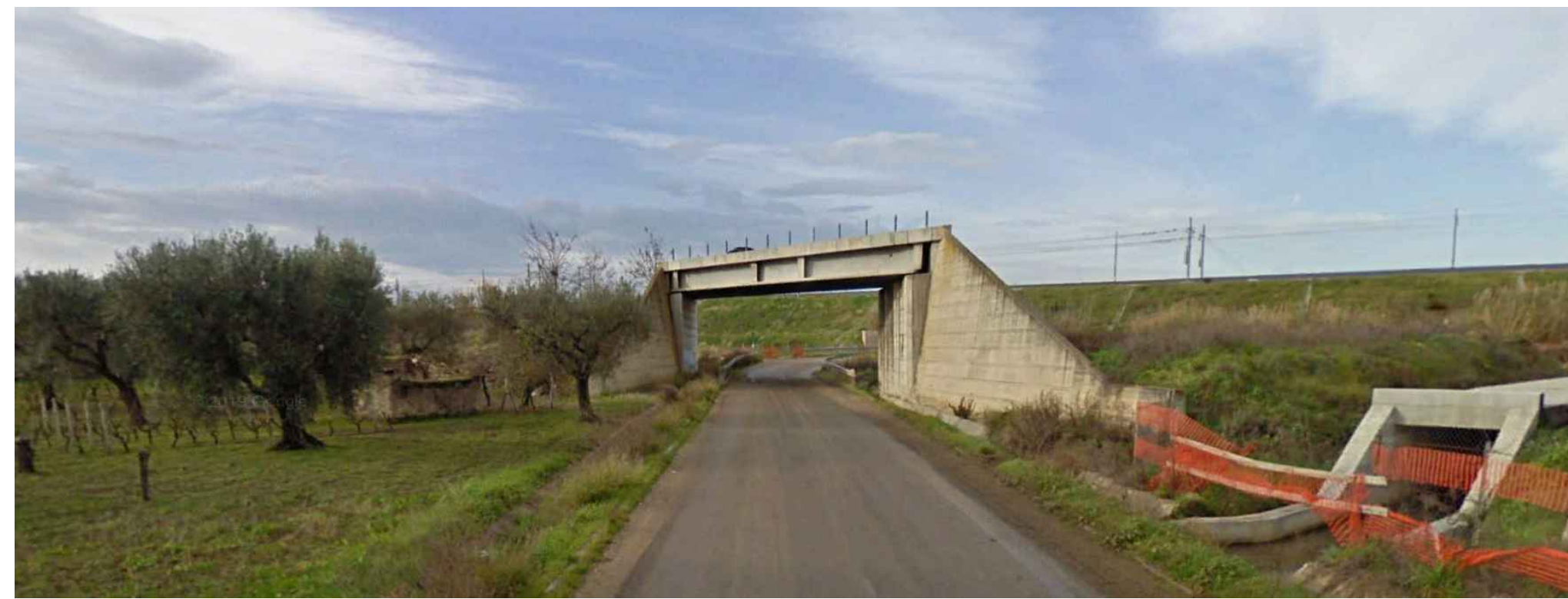
Foto B.5 - Attraversamento Ponte
