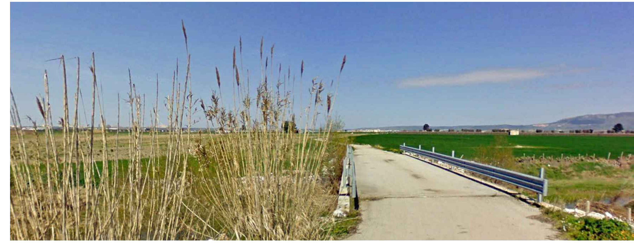
Foto INT.38 - Attraversamento Reticolo Idrografico e Ponte
