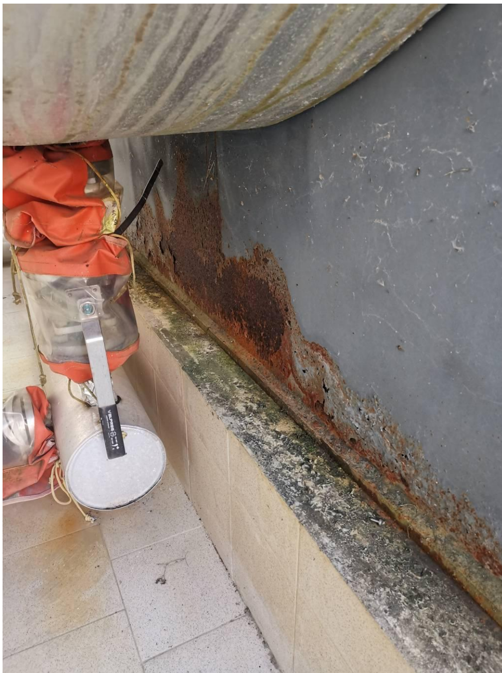
PARTICOLARE DELLA ZONA OSSIDATA (gambe serbatoio)
