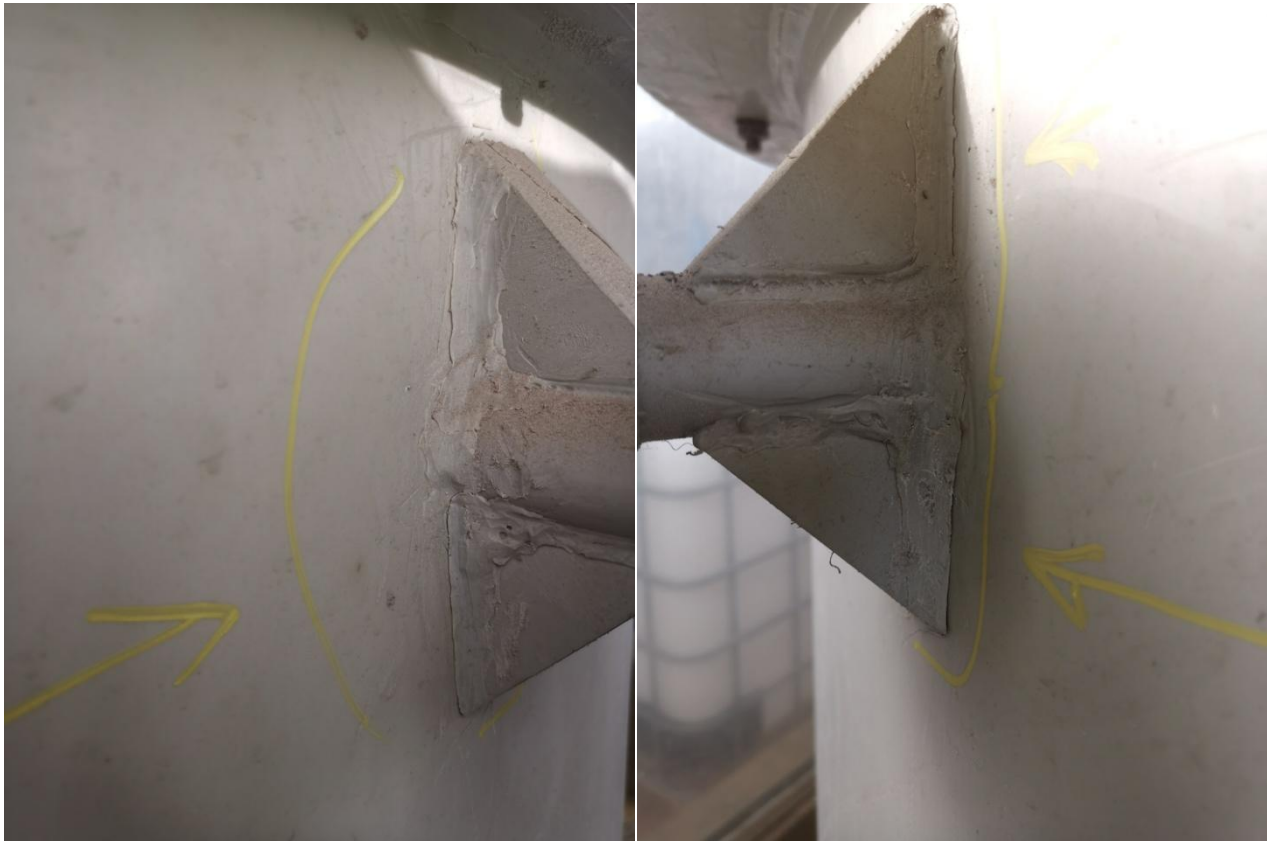
Particolare delle scollature sui fazzoletti di rinforzo
