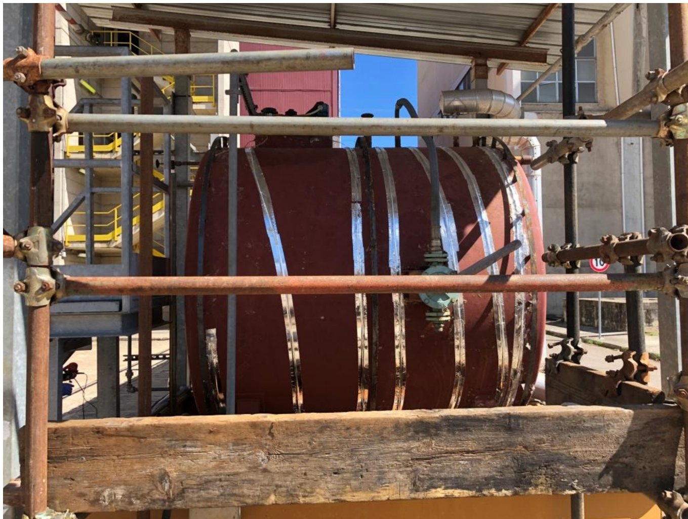
Immagine panoramica dell'apparecchiatura dopo scoibentazione
