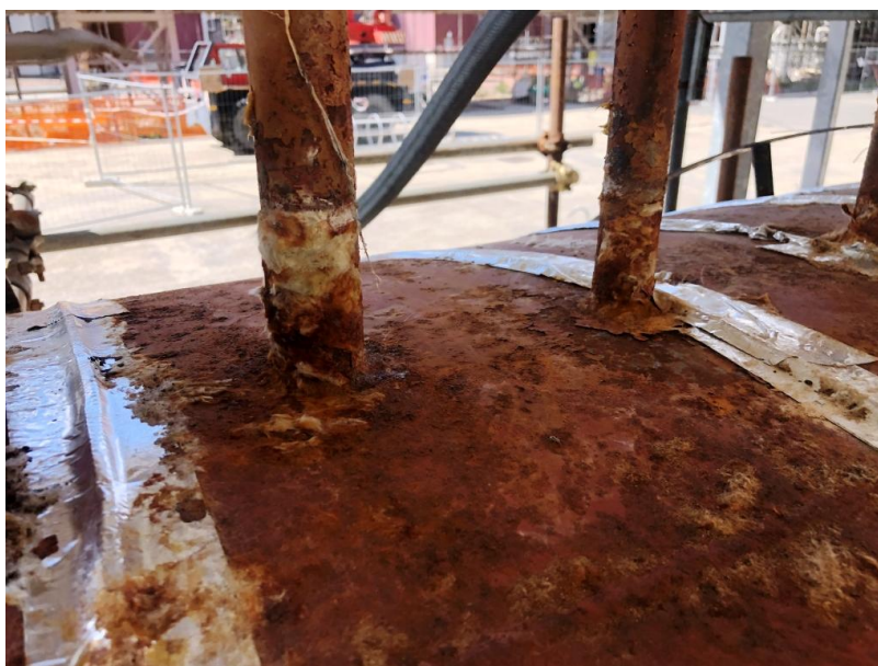
Immagine di dettaglio del fenomeno corrosivo in atto sul serbatoio
