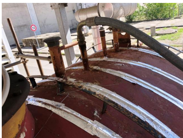
Immagini delle connessioni superiori, si noti il deterioramento della protezione superficiale e la corrosione in atto in prossimità delle saldature di giunzione tra tubazioni e mantello.
