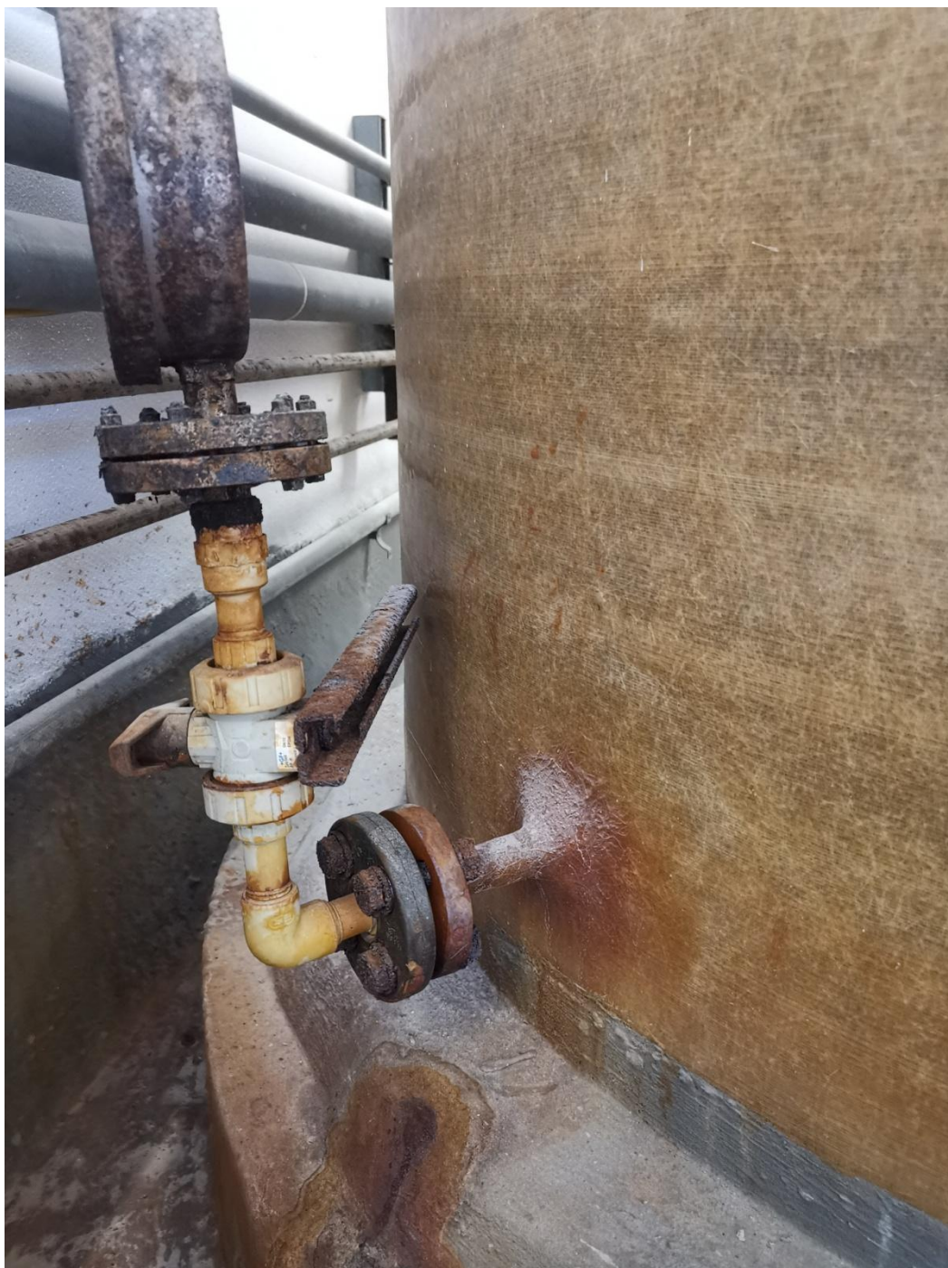
Particolare dello scarico di fondo del serbatoio cloruro ferrico TK1506
