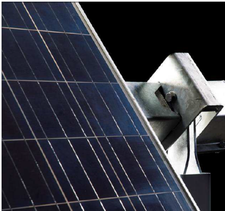
Figura 5 – Sistema di azionamento monoassiale +/- 55° dei Tracker.
