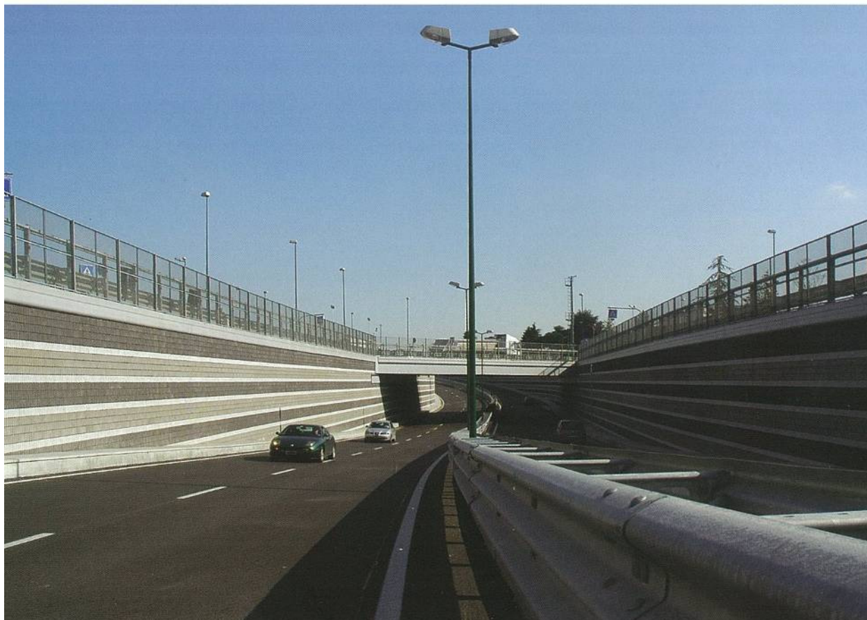
Figura 4 - rivestimento fonoassorbente per le gallerie
