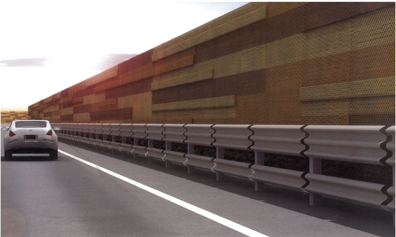
Figura 2 - Barriera in leca-cemento
