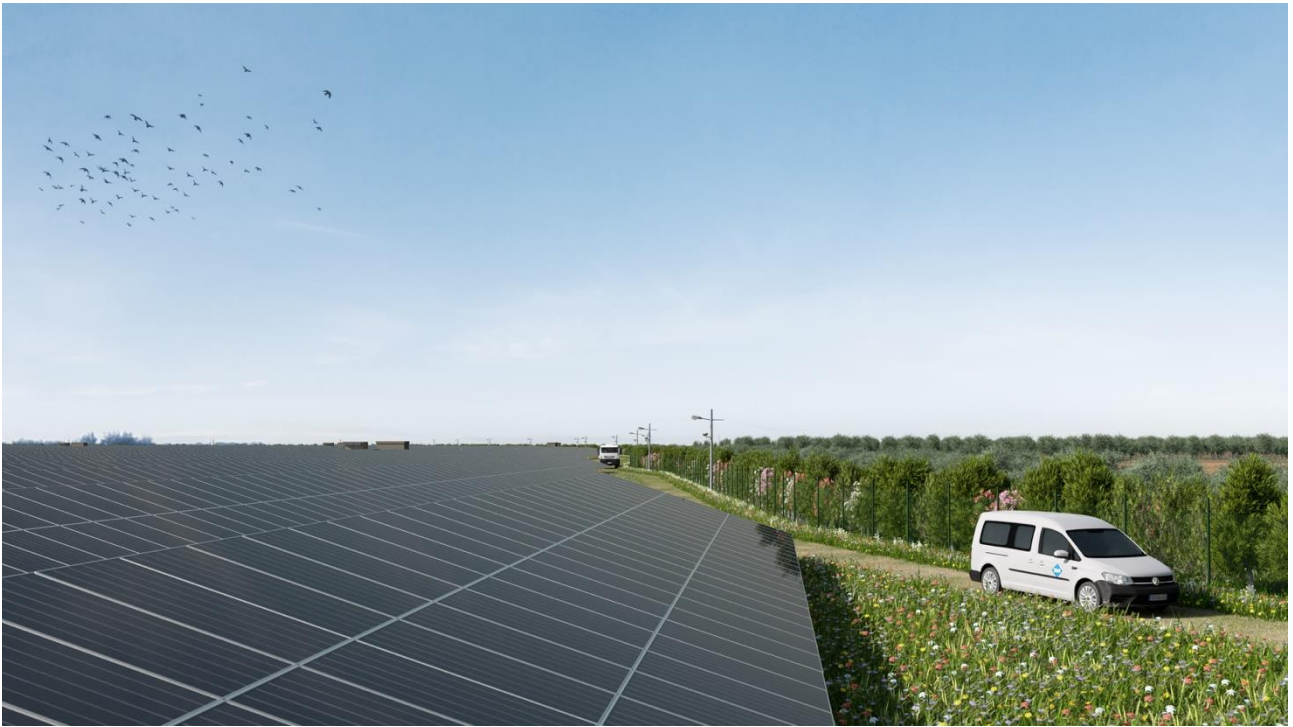
Figura 7: fotosimulazione (area impianto) – vista 1 - lato sud
