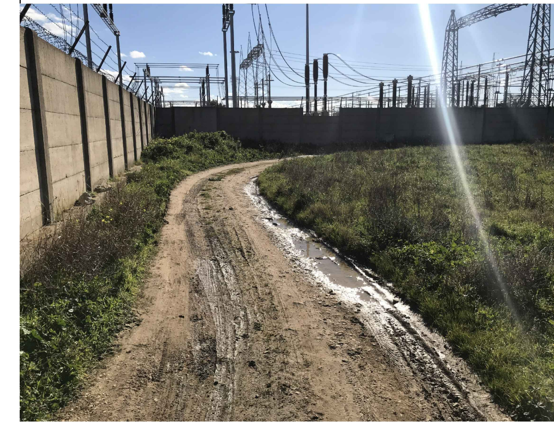
F10 - AREA STAZIONE ELETTRICA
