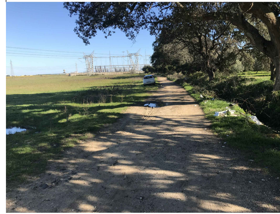
F7 - AREA STAZIONE ELETTRICA
