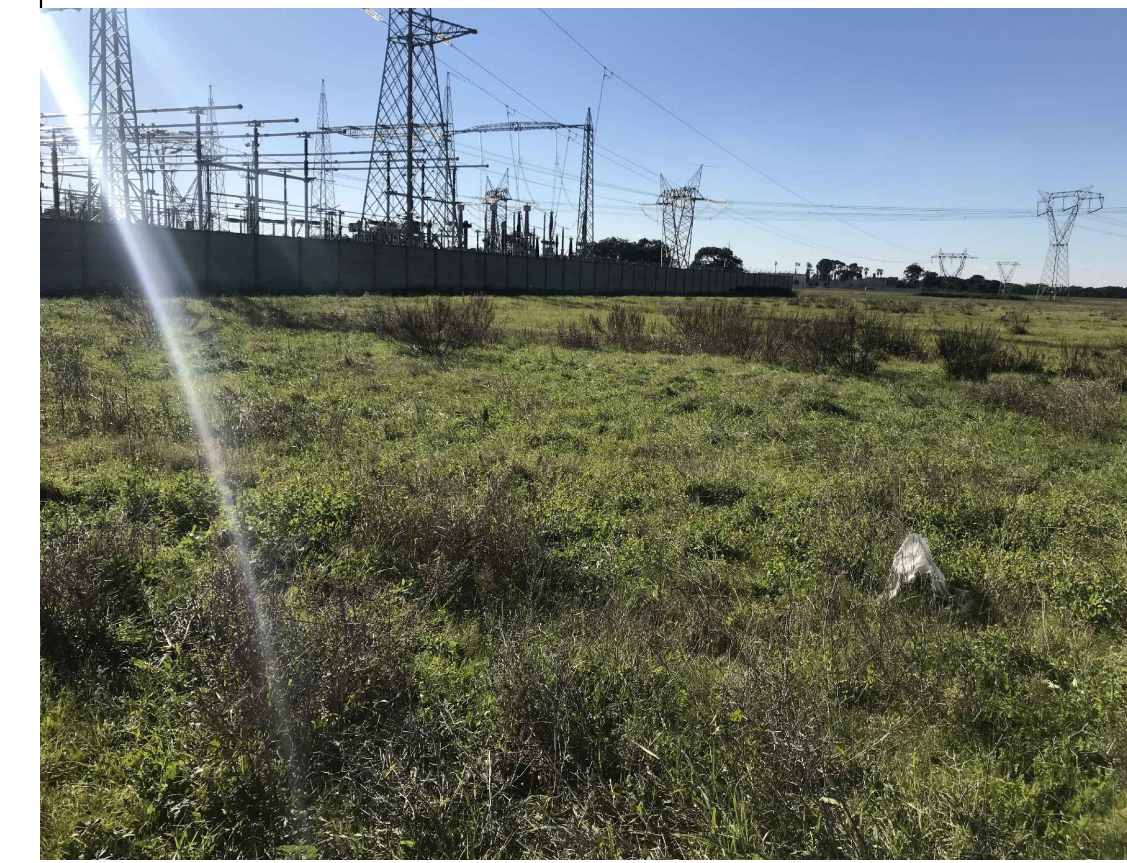
F11 - AREA STAZIONE ELETTRICA
