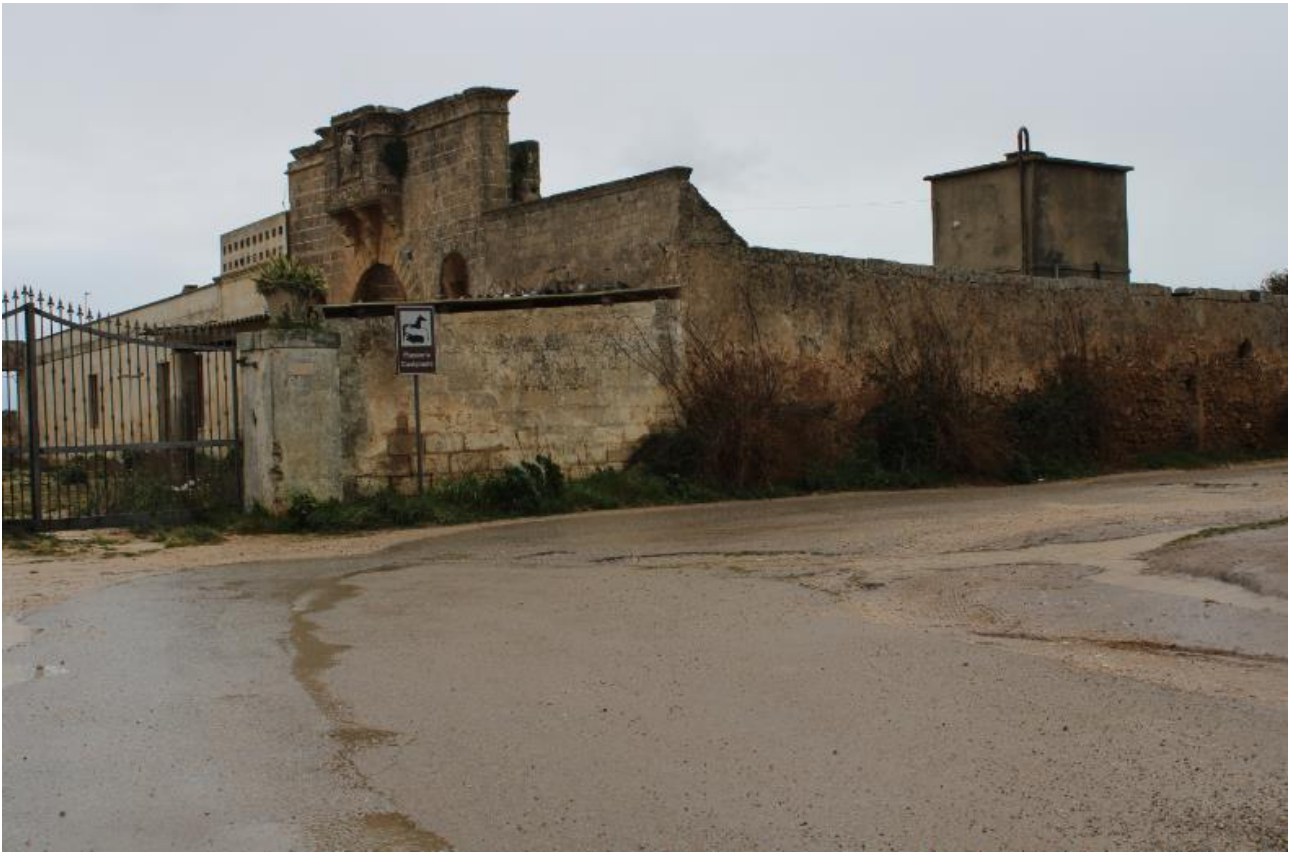
Figura 8-4 Masseria Casignano: ingresso e muro perimetrale (Strada Comunale n. 21).
