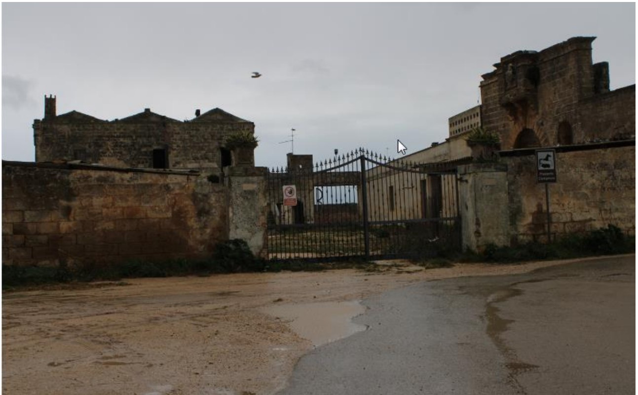
Figura 8-3 Masseria Casignano vista frontalmente.
