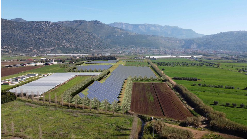
Fotoinserimento dell'impianto prima della dismissione
