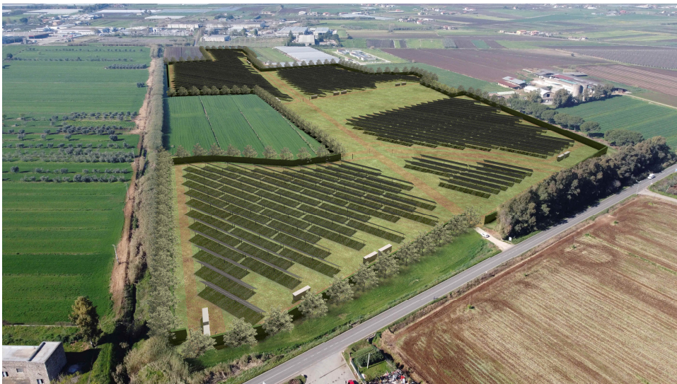
Fotoinserimento dell'impianto prima della dismissione
