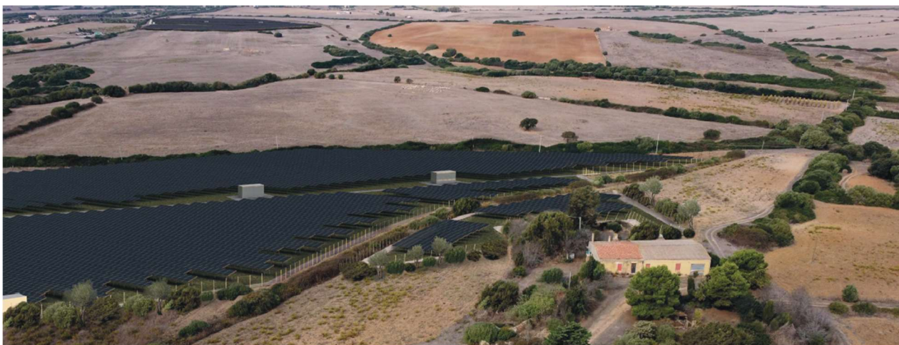
FIGURA 55 – INSERIMENTO DEL PROGETTO ALL'INTERNO DEL CONTESTO TERRITORIALE CON RELATIVE MISURE DI COMPENSAZIONE E MITIGAZIONE – VISTA A VERSO N-O IN CUI È POSSIBILE APPREZZARE ENTRAMBE LE PORZIONI DELL'IMPIANTO – ESTRATTO DALL'ELABORATO GRAFICO STINTINO-IAT17
