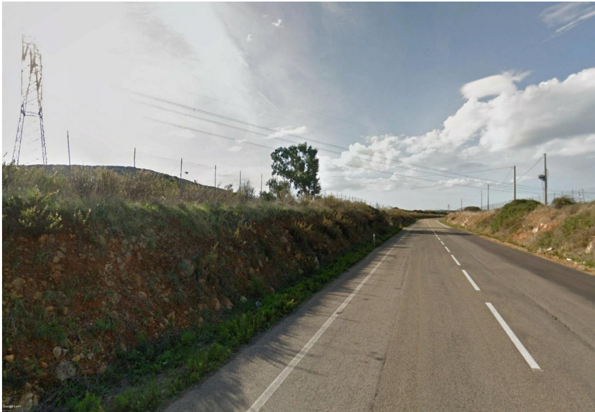
Figura 32: Vista dal punto 5_ strada SP 57
