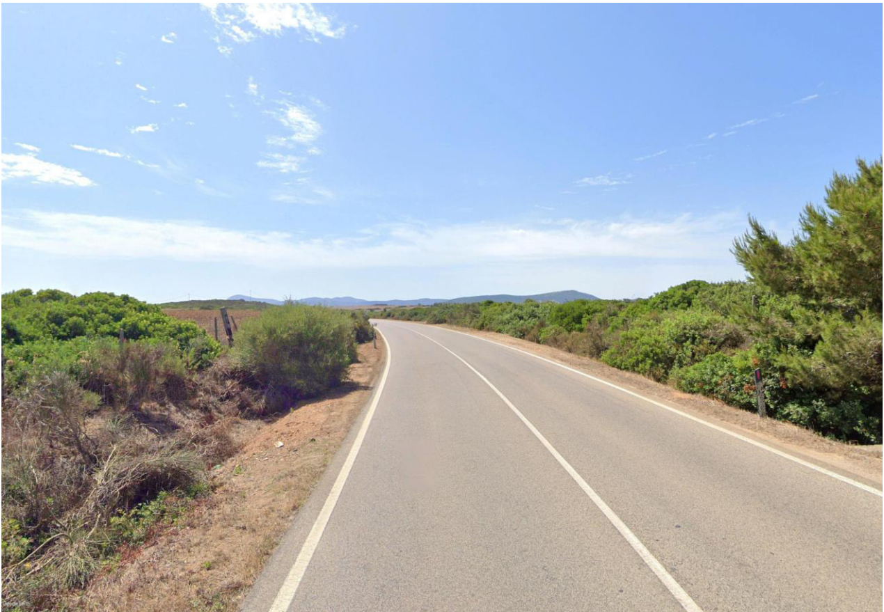
Figura 26: Vista dal punto 2_ strada SP 34_ verso l'area di impianto
