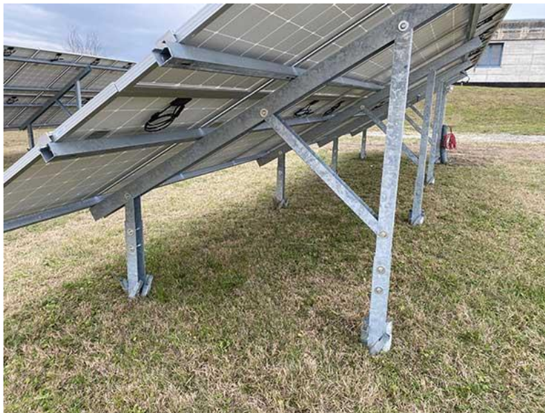
FIGURA 1: ESEMPIO DI STRUTTURA FISSA
