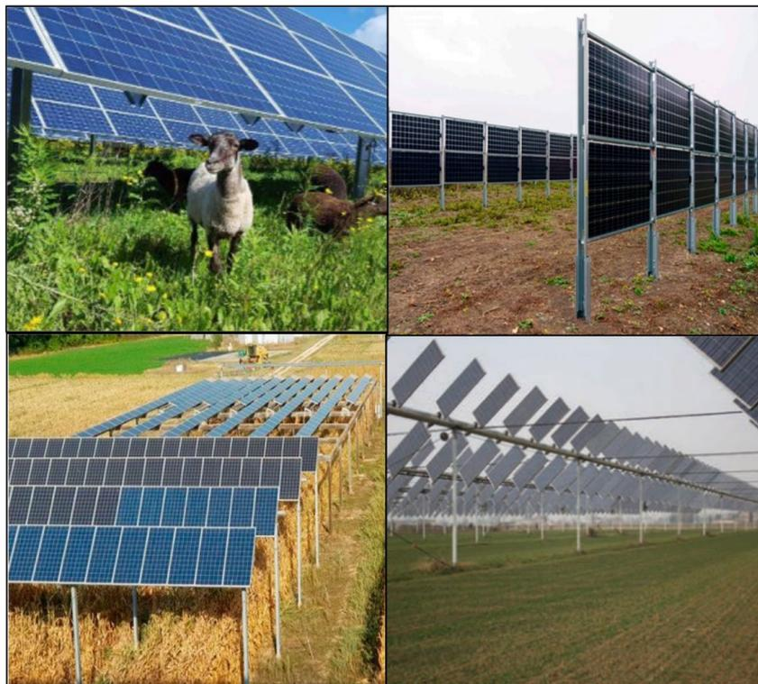
**Figura 4.** Soluzioni agrivoltaiche. impianti fissi (Legambiente, 2020), moduli verticali, sistemi di inseguimento (Toledo e Scognamiglio, 2021), Agrovoltaico® (<https://remtec.energy/agrovoltaico>).
