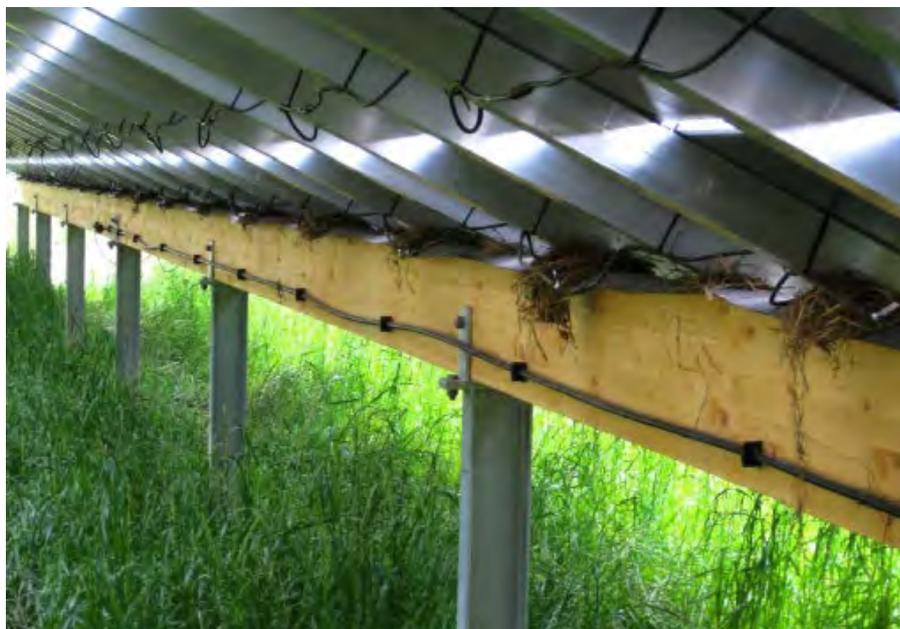
Figura 93. Nidi su strutture di sostegno.
