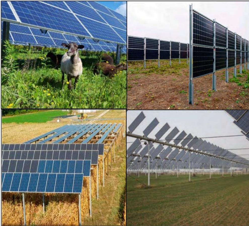
Figura 24. Soluzioni agrivoltaiche. impianti fissi (Legambiente, 2020), moduli verticali, sistemi di inseguimento (Toledo e Scognamiglio, 2021), Agrovoltaico® (<https://remtec.energy/agrovoltaico>).
