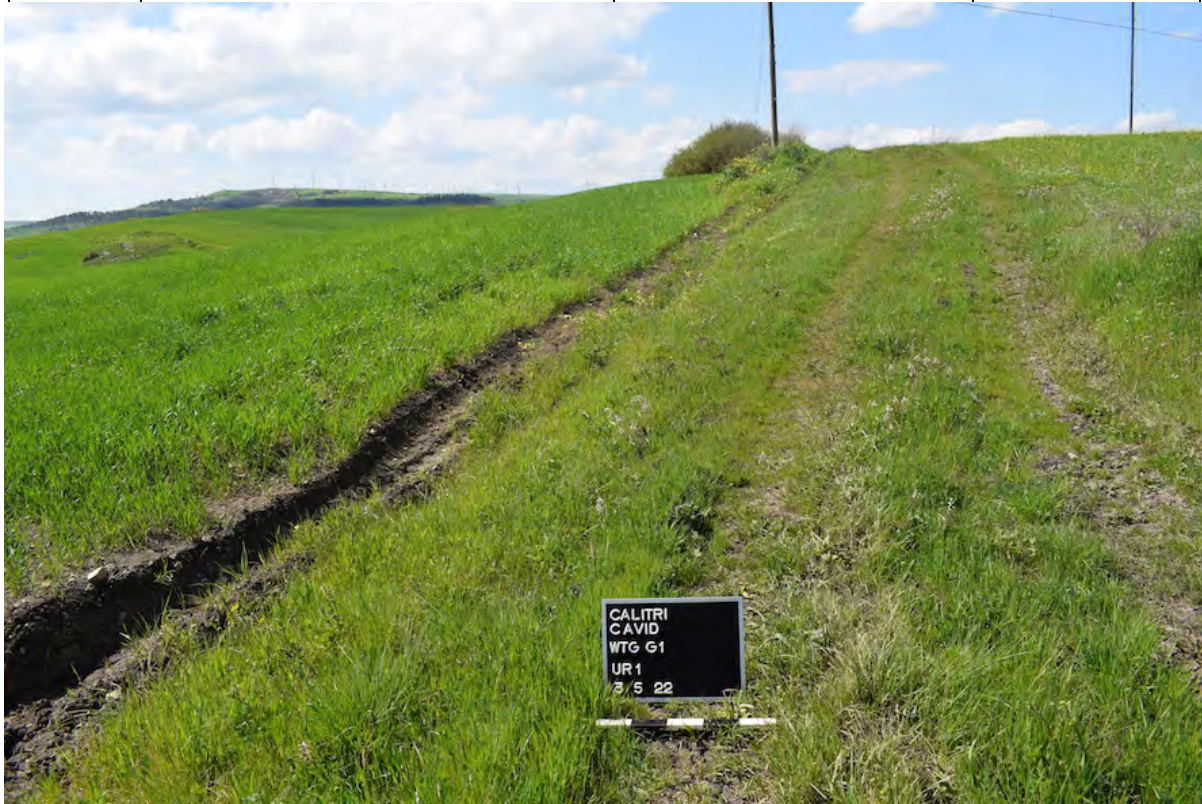
Foto 15 | Cavidotto, pista di accesso WTG G1 | Coordinate: 40°57'35.18"N 15°25'02.91"E
