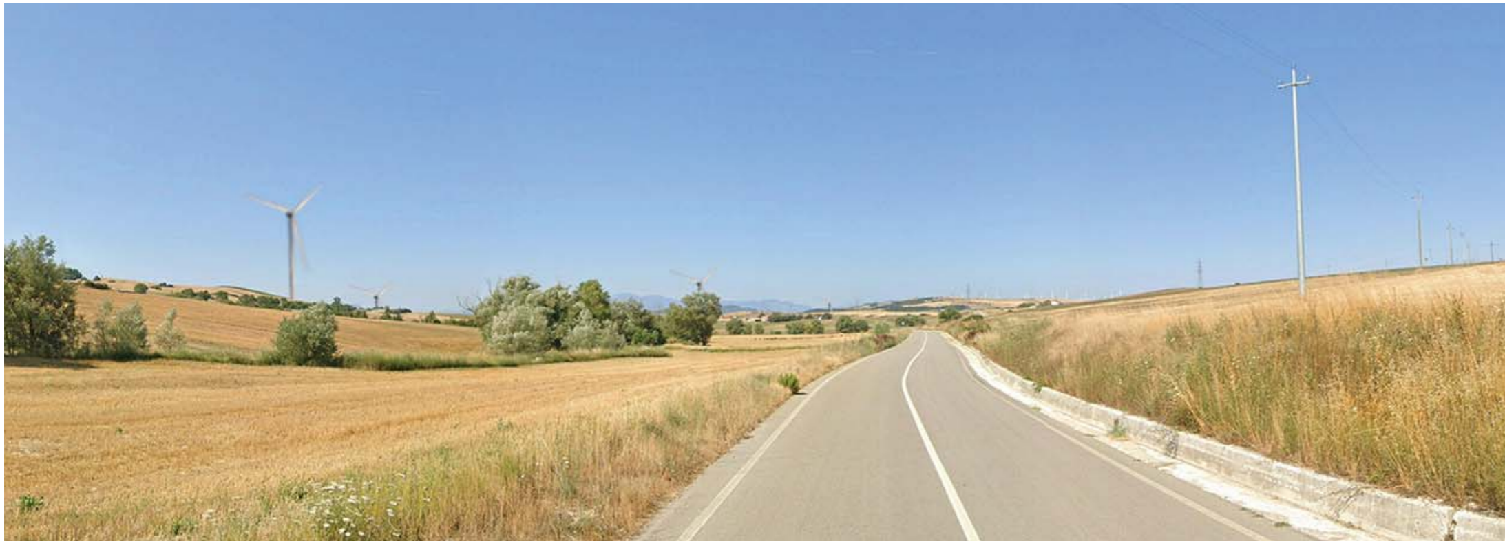
VISTA PANORAMICA 40 C.da Acquariello - SP51 in direzione Sud (Comune di Bisaccia)
