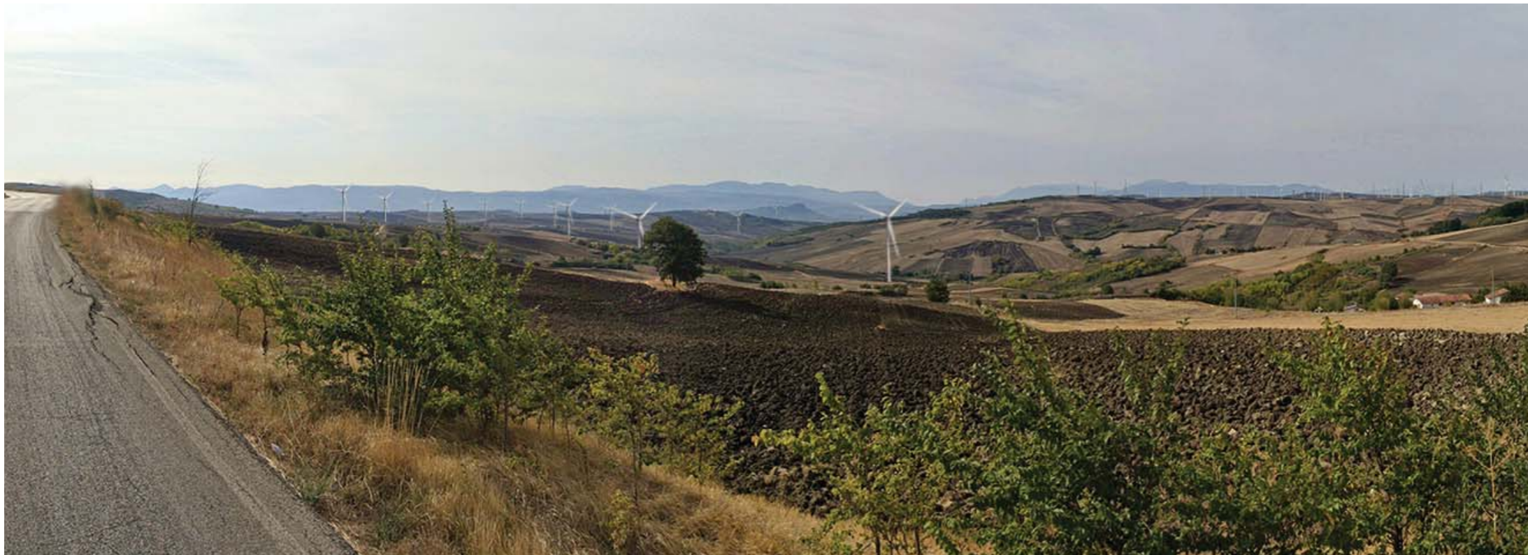
VISTA PANORAMICA 16 Limite Centro Urbano Bisaccia in direzione Sud - SS399
