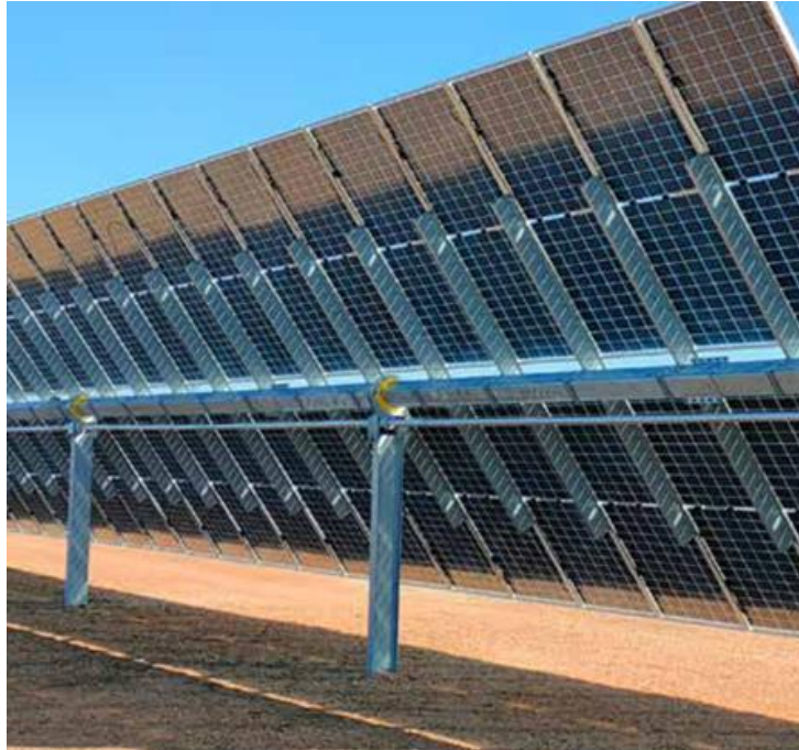
Figura 5 - Inseguitori mono assiali (Est-Ovest)
