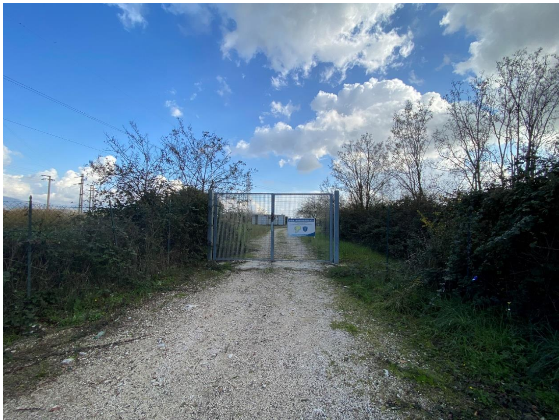
Figura 40 - Foto dello STATO DI FATTO dell'area delle cabine di consegna dal punto di osservazione n. 3B lungo Via Nettuno
