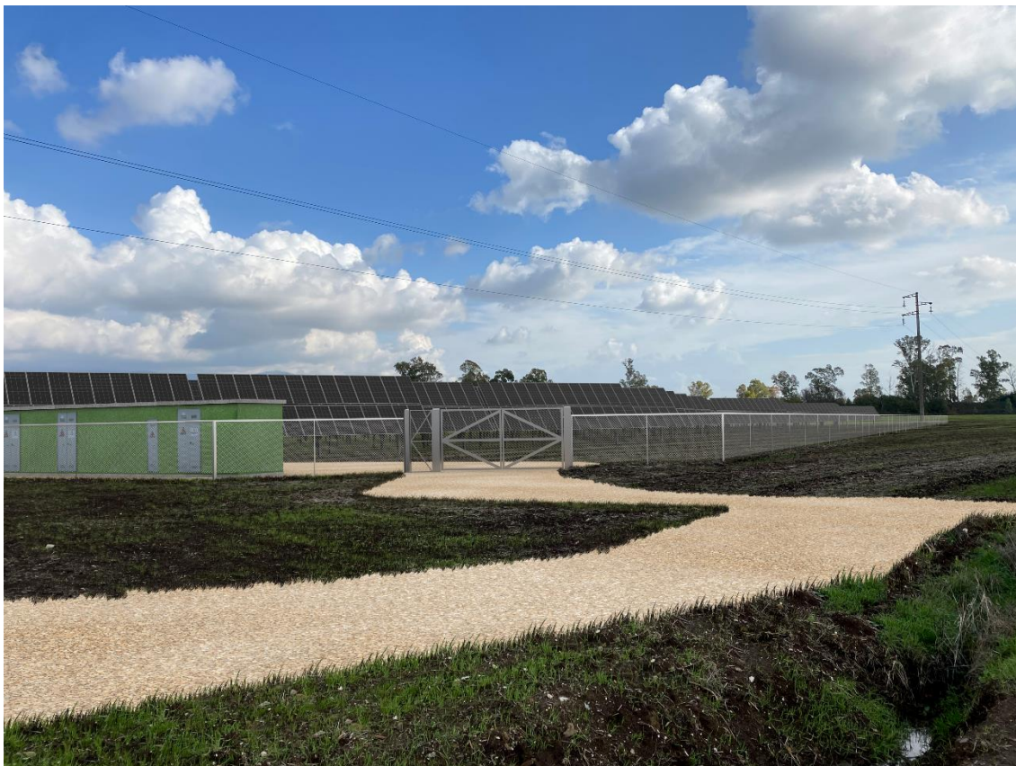
Figura 35 - Fotoinserimento dell'impianto agrovoltaico CACCIANOVA senza opere di mitigazione nell'area di progetto dal punto di osservazione n. 2B lungo Via del Pettiroso
