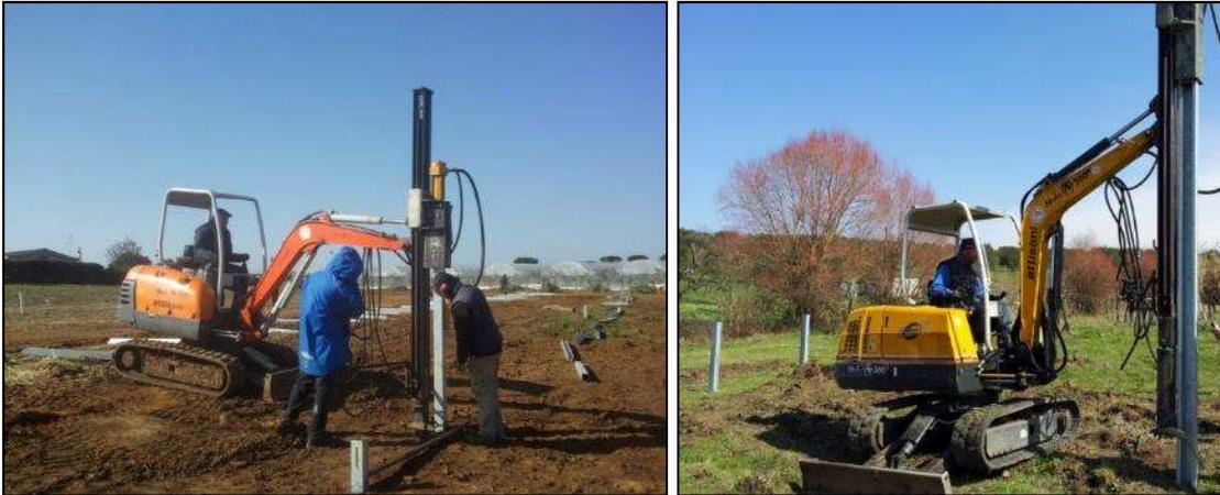
*Figura 29 - Tipologia di installazione delle strutture di sostegno dei moduli FTV con macchina battipalo*
