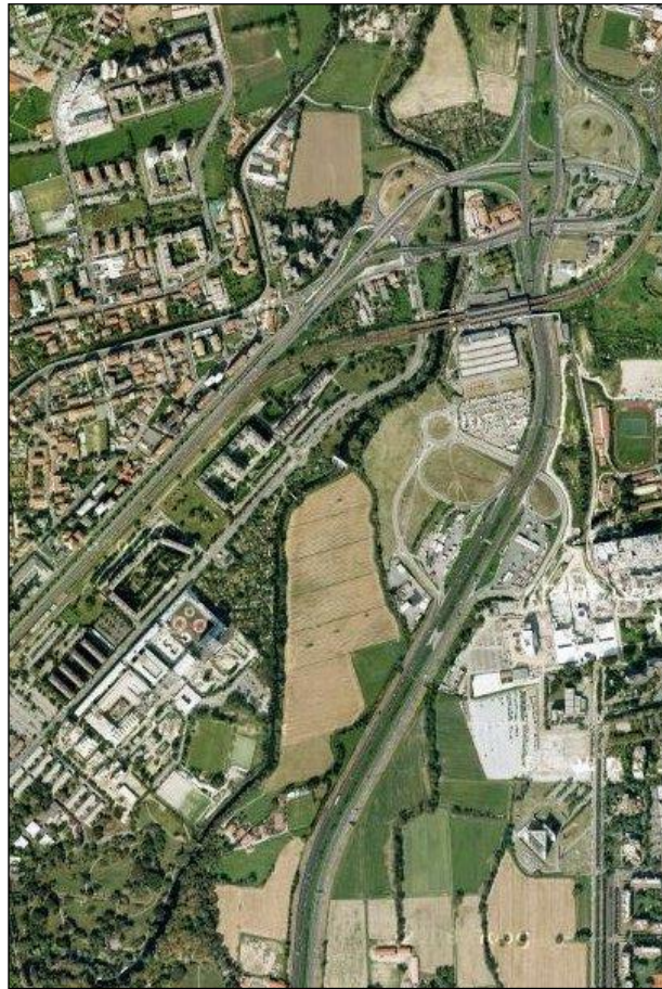
Figura 4-13. Foto Aerea dell'area di studio
