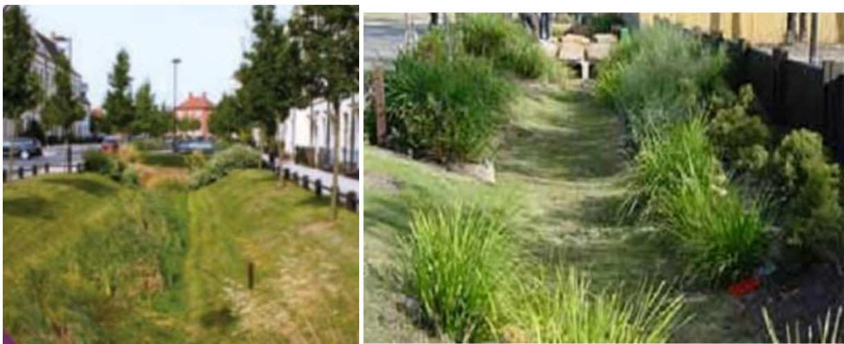
Figura 29: Esempi di depressione con funzione di laminazione
