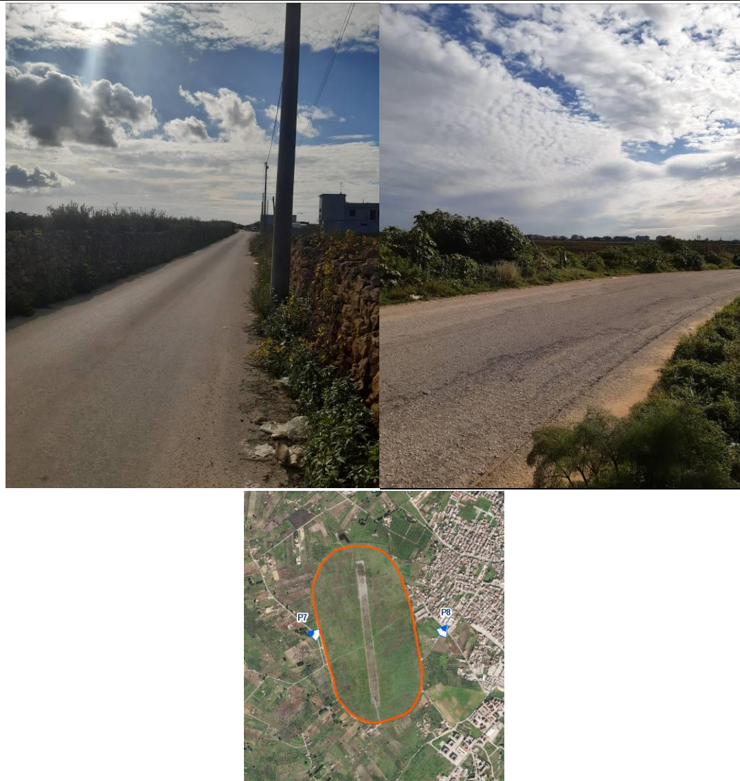
Figura 7.5 Visuale da viabilità locale e secondaria verso il sito di progetto
