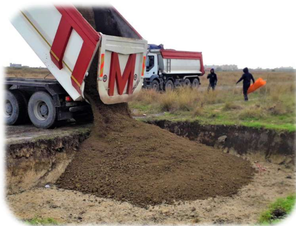
FOTO 14: Viene dato seguito al ripristino dello stato dei luoghi, mediante riempimento con terreno, della stessa tipologia di quello precedentemente rimosso
