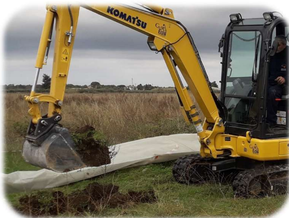
FOTO 4: Interventi MISE, asportazione delle matrici coinvolte: vengono attuate azioni di rimozione di terreno mediante macchine operatrici, 17/12/2020
