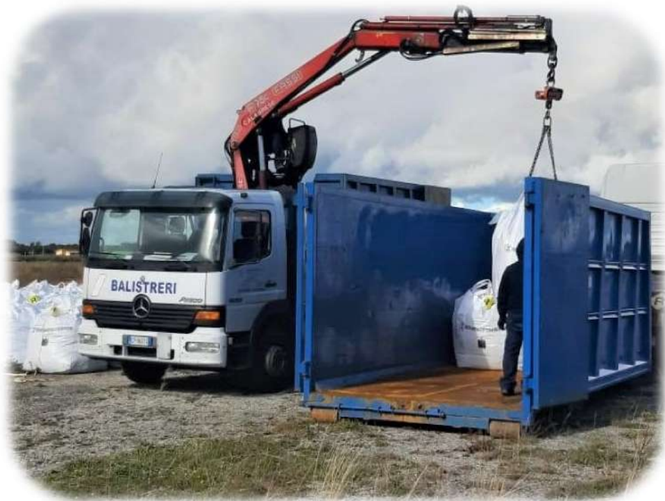
FOTO 12: A seguito dell'avvenuto riscontro delle certificazioni analitiche, si procede con lo smaltimento dei rifiuti agli impianti autorizzati, 04 e 05/01/2021
