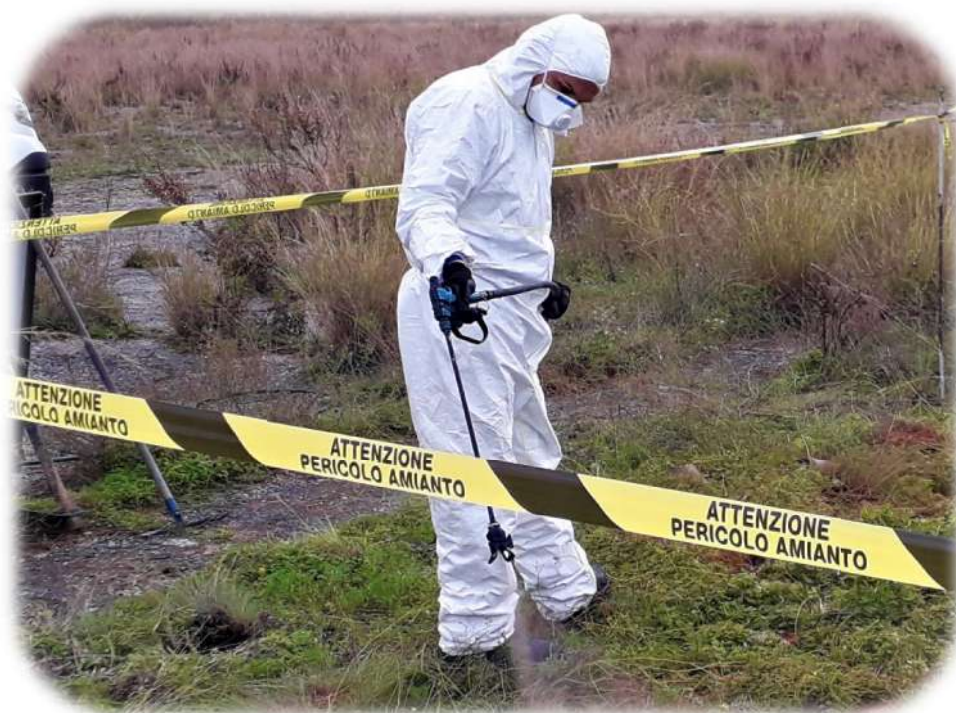
FOTO 3: Interventi MISE, riguardanti la bonifica di beni contenenti amianto: trattamento con incapsulamento attraverso prodotti biodegradabili, Biofix , 17/12/2020
