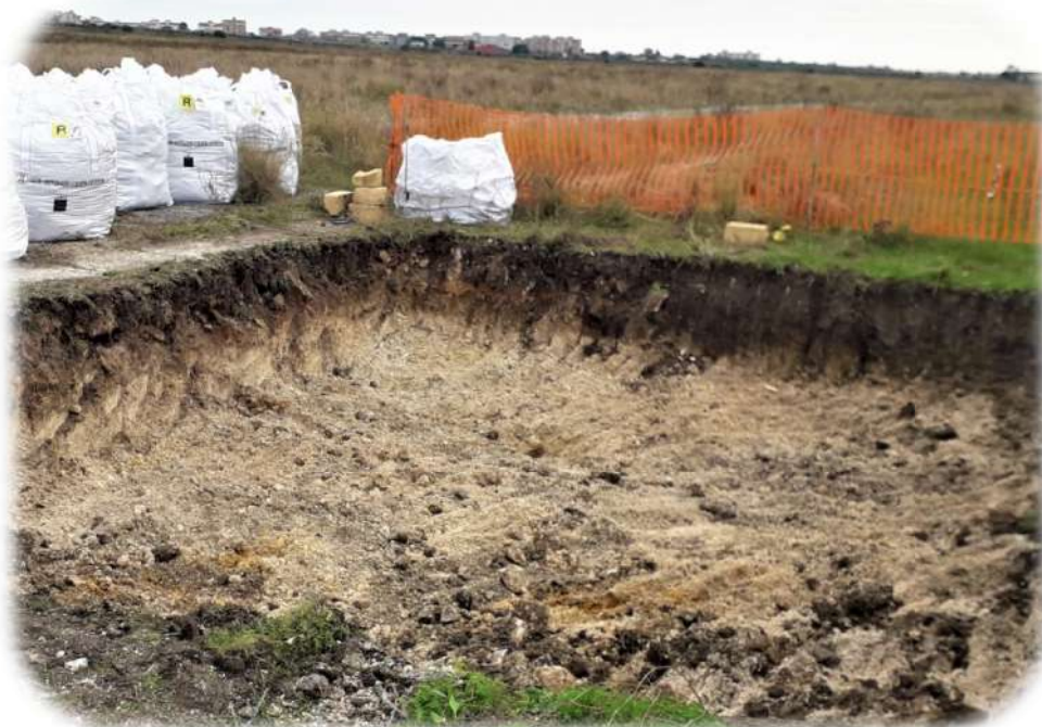
FOTO 8: Livellamento dello scavo a sezione obbligata, di concerto col “Soggetto interessato”, alla quota di 1 m. di profondità dal piano di campagna
