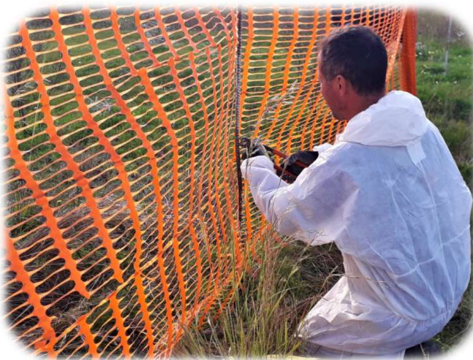
FOTO 2: Predisposizione cantiere, recinzione ed apposita cartellonistica, e rimozione delle misure preventive precedentemente applicate, 17/12/2020
