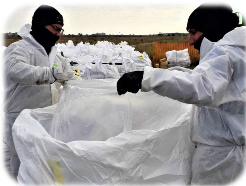
FOTO 5: Rimozione dei rifiuti prodotti consistenti in materiali contenenti amianto e del terreno interessato dallo sversamento accidentale
