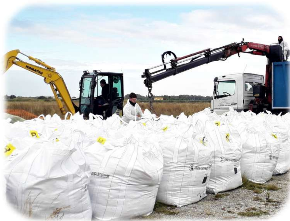
FOTO 7: Confezionamento dei rifiuti in idonei imballi, big bag, con adeguati requisiti in relazione alle proprietà e caratteristiche dei rifiuti
