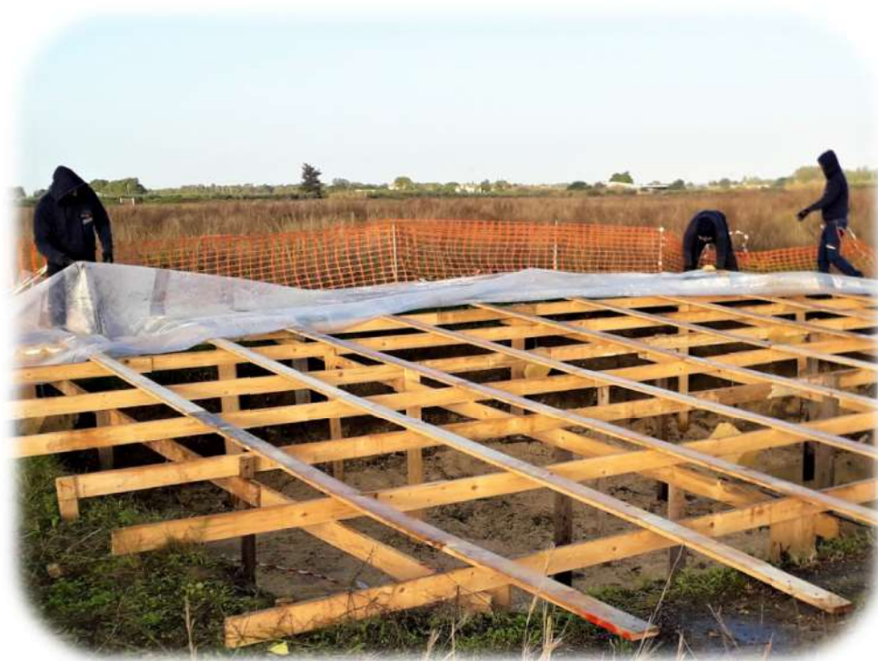
FOTO 13: Ripresa delle attività, in data 07/01/2021 , mediante la rimozione definitiva delle misure preventive consistenti nella struttura con teli in polietilene a bassa densità
