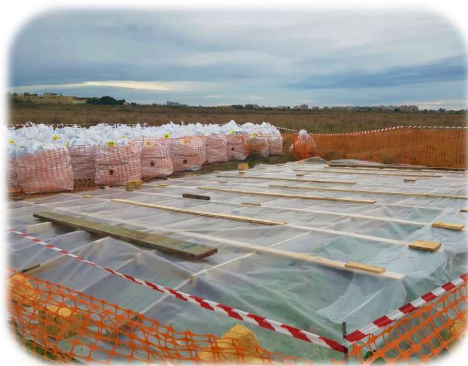
FOTO 10: Completamento operazioni scavo e asportazione del terreno, nonché nuova copertura e ridelimitazione area, resa inaccessibile a “non addetti ai lavori”, 19/12/2020
