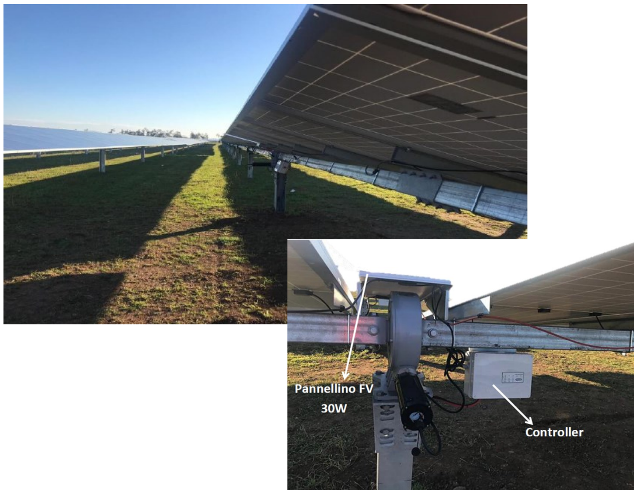
Figura 7- Strutture di supporto dei moduli
