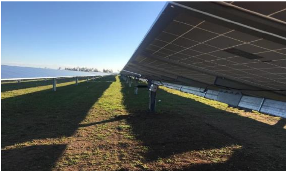
Figura 16: Inseguitore monoassiale tipo
