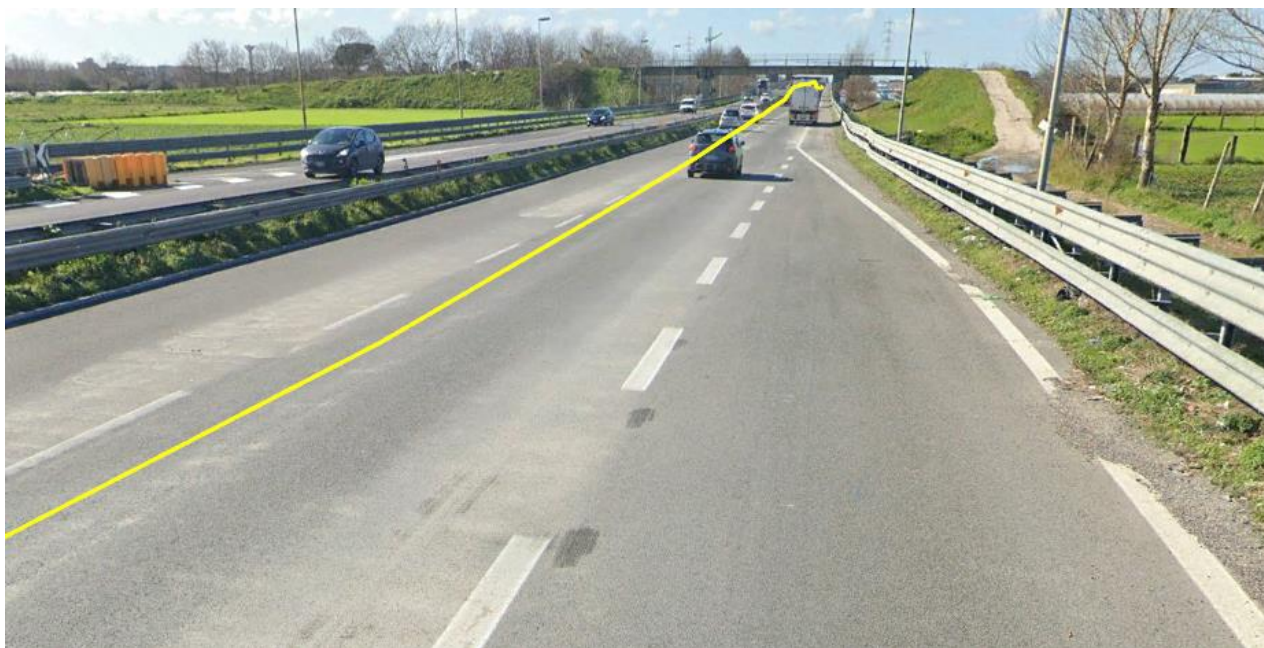
Figura 4: PUNTO 2 - Ingresso s sulla SS7bis "Pomigliano-Villa Literno"
