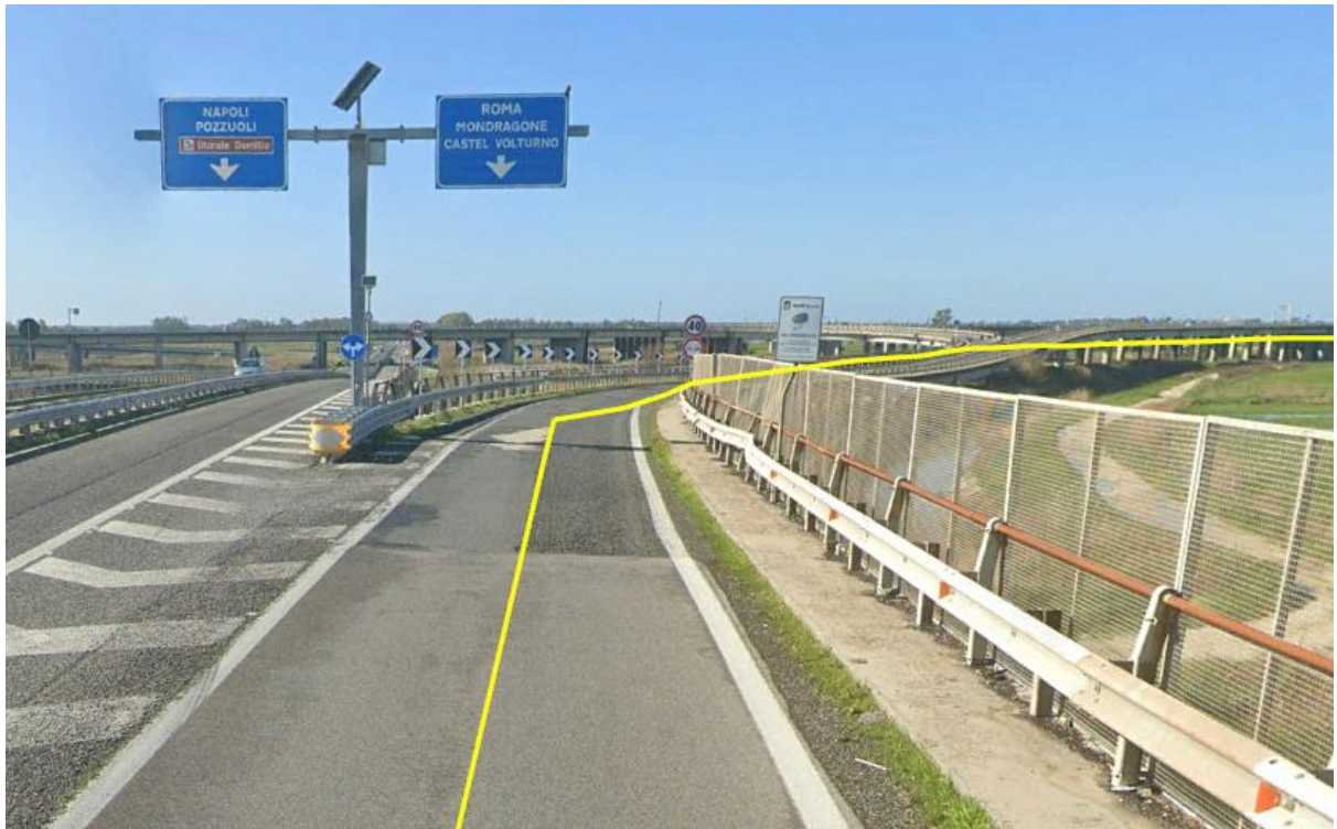
Figura 6: PUNTO3- Svincolo di uscita per ingresso sulla SS7qtr direzione Castelvolturno
