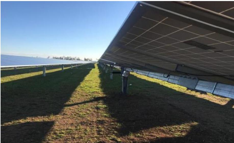
Foto 1 – Foto di esempio della struttura inseguitore monoassiale
