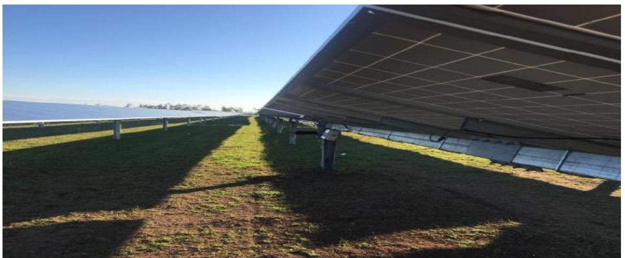
Figura 3 Inseguitore monoassiale tipo
