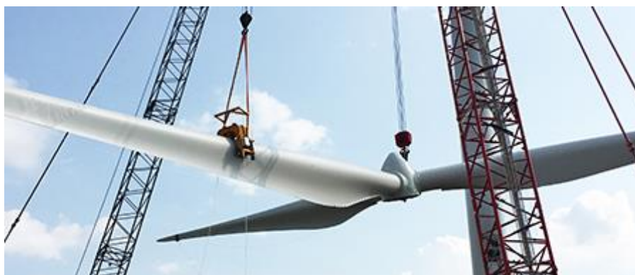
Figura 6-5 – Sollevamento del rotore (Fonte: Elronic Wind solution)
