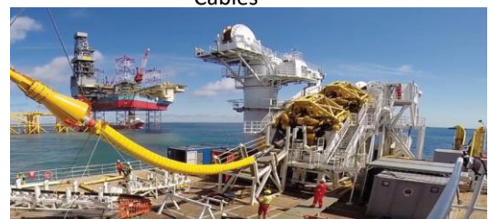
Figura 22 - Particolare dell'imbarcazione posa cavi - NKT Cables
