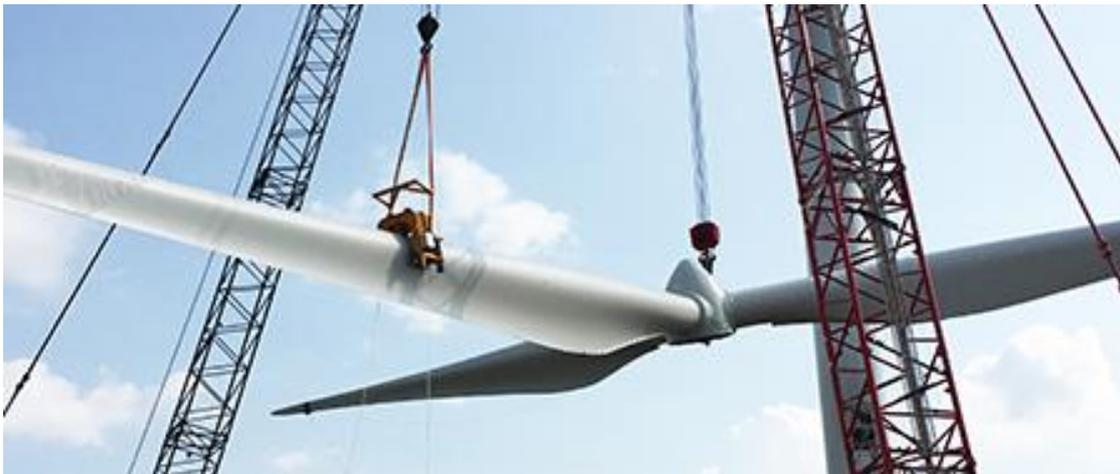
**Figura 2-27 – sollevamento del rotore (Fonte: Elronic Wind solution)**
