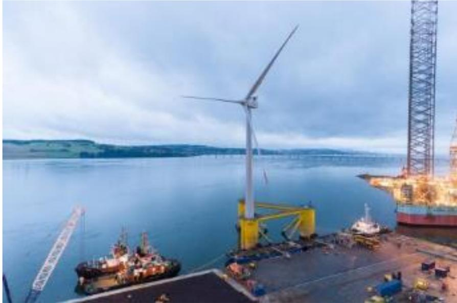
**Figura 2-24 – Assemblaggio piattaforma galleggiante (Fonte kinkardine - Cobra)**
