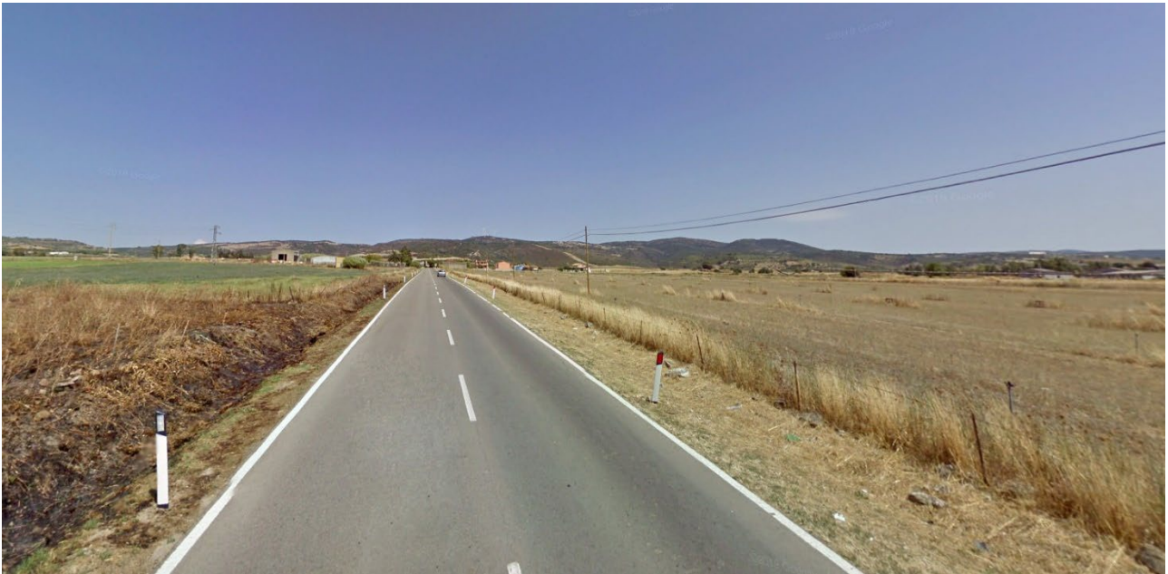
Vista n.01_Stato di fatto.
