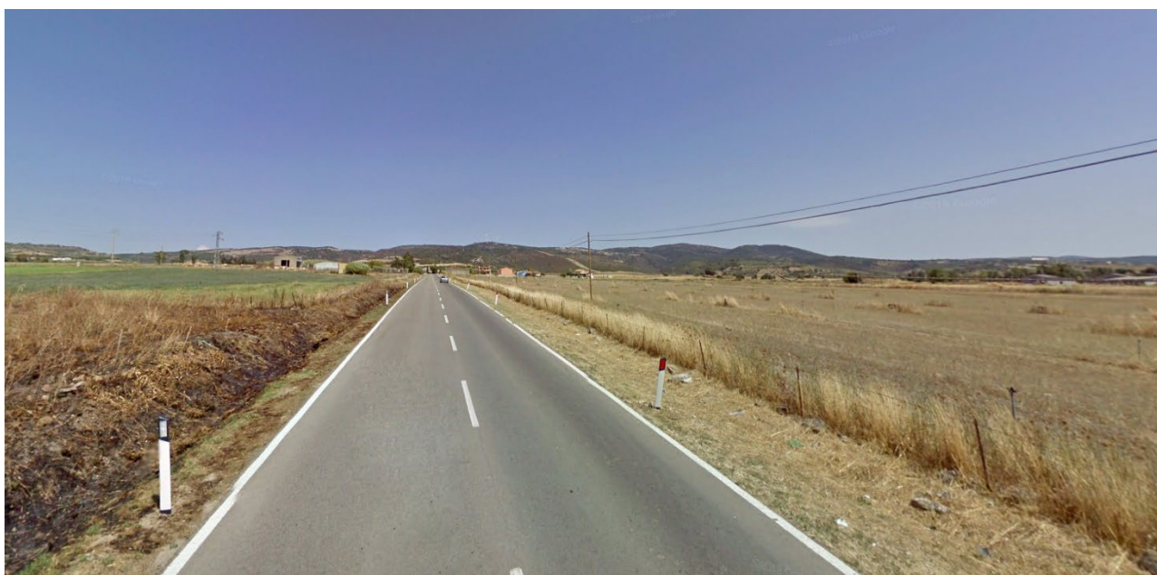
Vista n.01_Stato di fatto.
