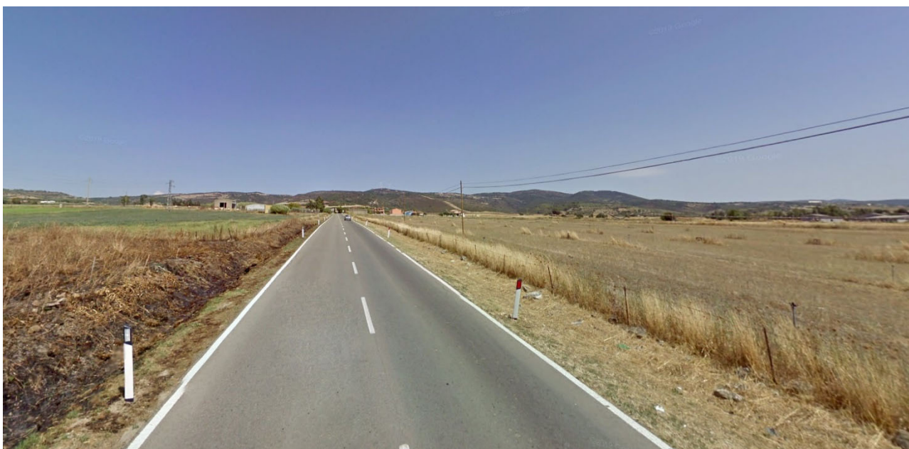
Vista n.01_Stato di fatto.
