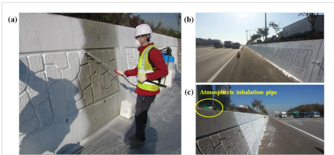
Figura 35. Applicazione vernice contenente TiO 2
