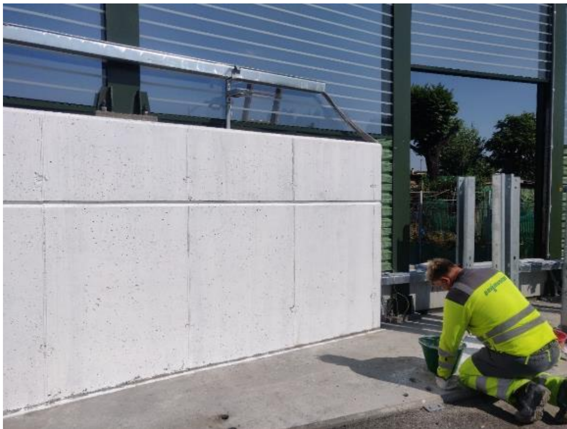
Figura 16. Stesa della vernice
