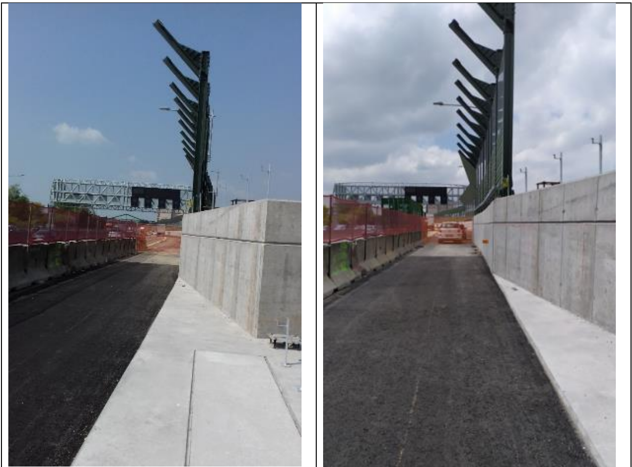
Figura 9. Individuazione e localizzazione del sito di installazione del materiale fotocatalitico: lato carreggiata
