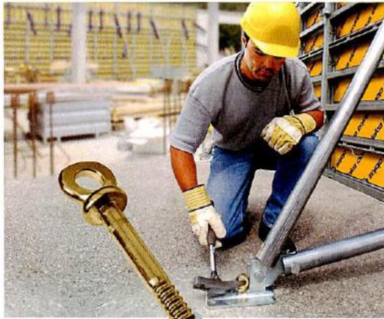
32. Ancorante espresso Doka e sua modalità di fissaggio
