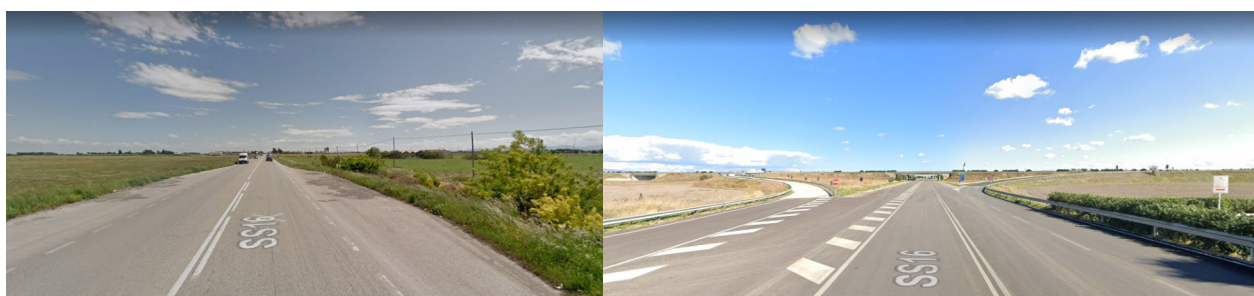
Figura 1 – “Viste dello stato attuale della Tangenziale di Foggia”
