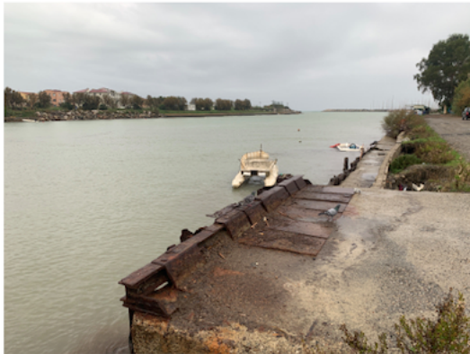
Foto 11. Panoramica banchine e canale di sbocco a mare
