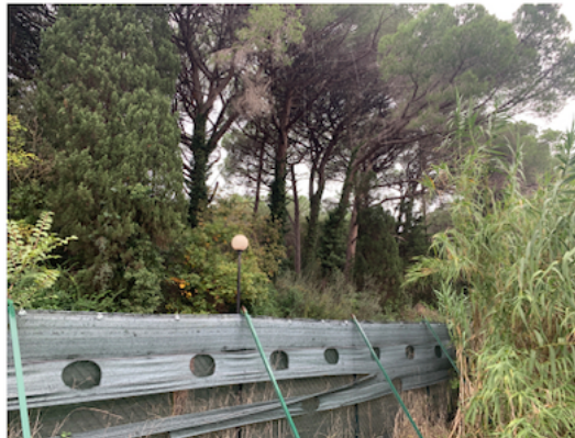
Foto 8. Particolare recinzione perimetrale tra la ZPS e il confine dell'area di intervento
