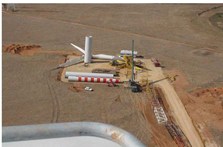
Figura 2 – Piazzola per il montaggio dell'aerogeneratore
