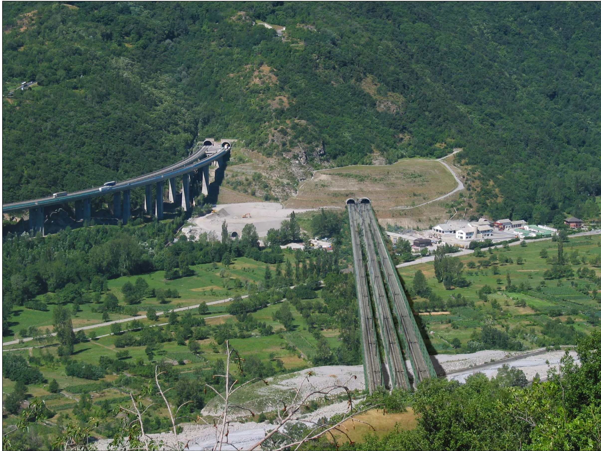
Vista 5: Fotoinserimento del viadotto di attraversamento della Val Cenischia con imbocco del tunnel di base, visto dal versante in sinistra orografica del torrente.
