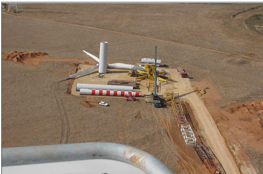
Foto 1. Piazzola per il montaggio dell'aerogeneratore
