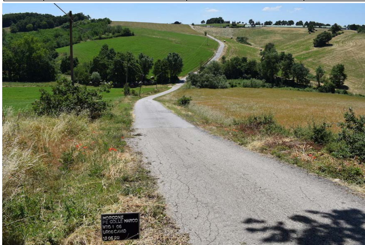
Foto 38 | Cavidotto collegamento WTG06-01 | Coordinate: 41°23'33.68"N | 14°41'20.12"E
