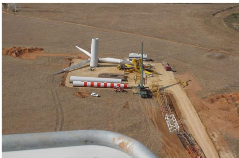
Figura 19 – Piazzola per il montaggio dell'aerogeneratore
