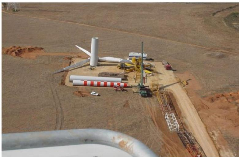
Figura 7 – Piazzola per il montaggio dell'aerogeneratore
