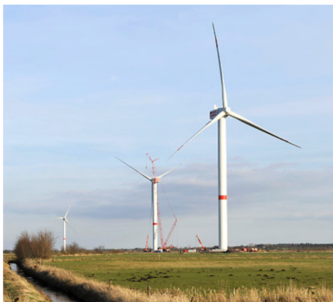
Figura 2-1 Westre wind farm (confine tra Germania e Danimarca – marzo 2009) - 3 aerogeneratori REpower 6M in fase di test
