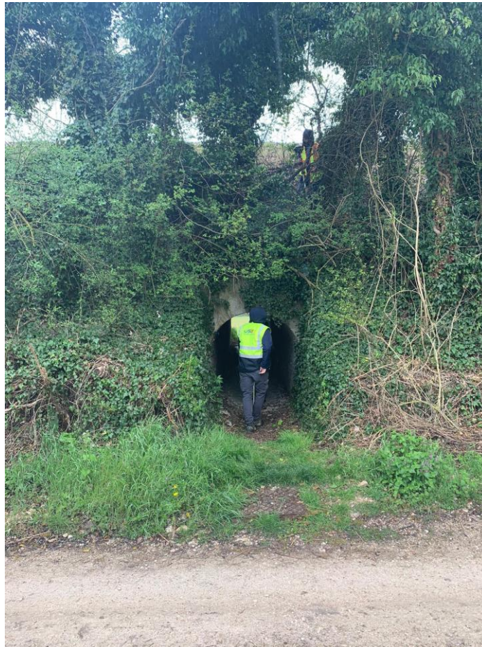
Figure 9 Opera 6 - Vista Nord
