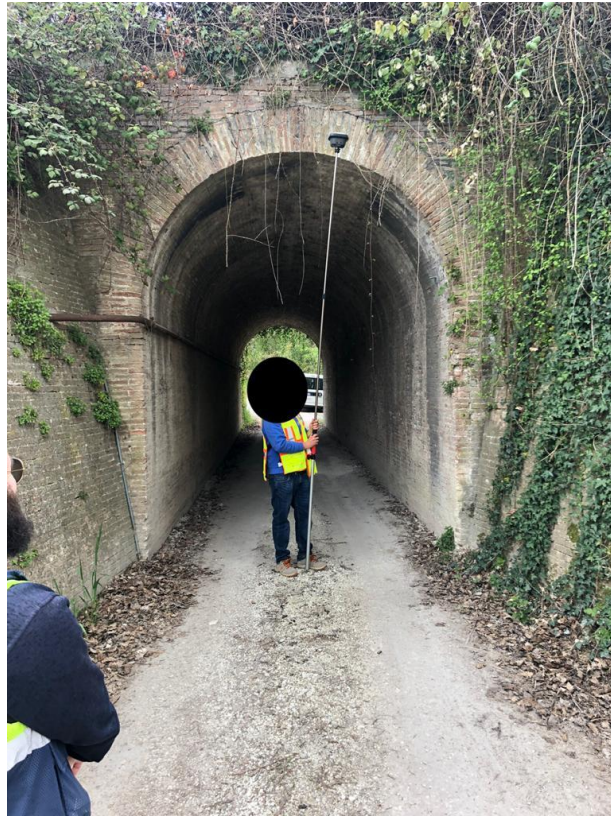
Figure 7 Opera 5 - Vista Nord
