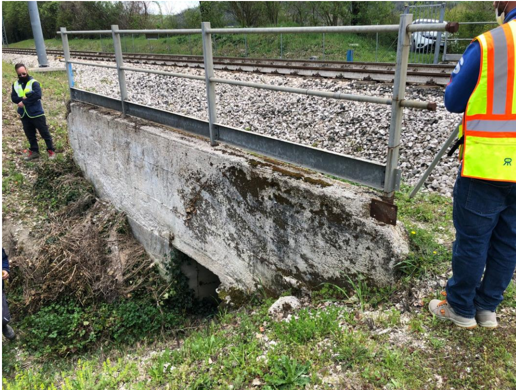
Figure 2 Opera 2 - Vista Nord
