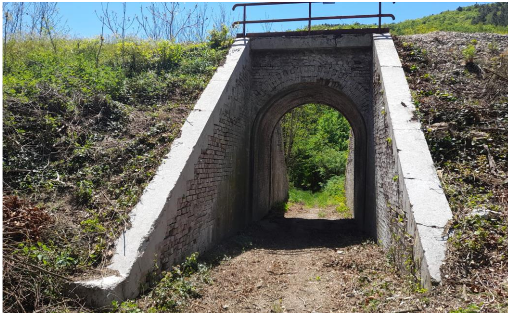
Figure 21 Opera 22 - Vista Nord
