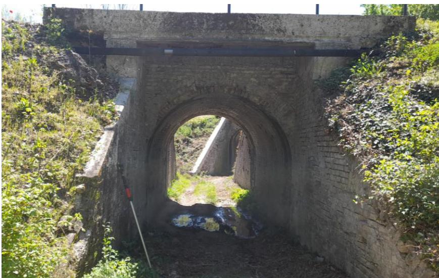
Figure 19 Opera 21 - Vista Nord
