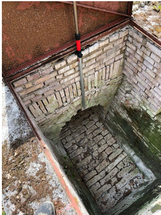
Figure 3 Opera 3 - Vista Nord
