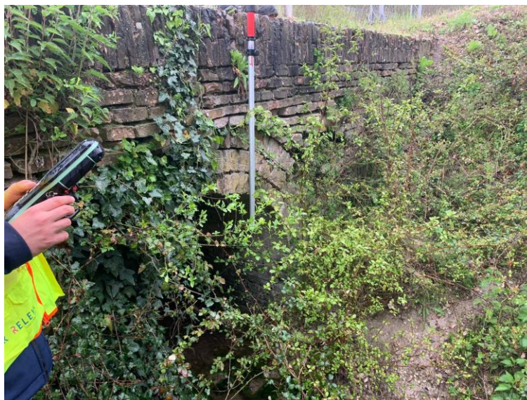
Figure 16 Opera 9 - Vista Nord
