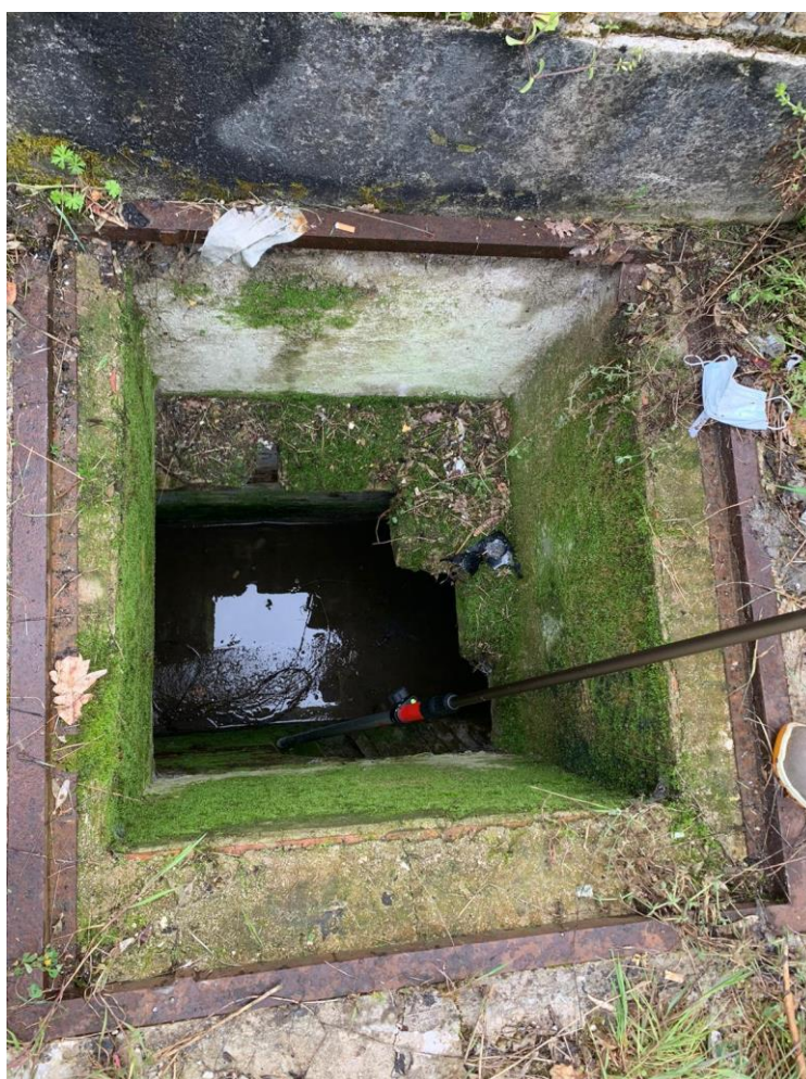
Figure 5 Opera 4 - Vista Nord
