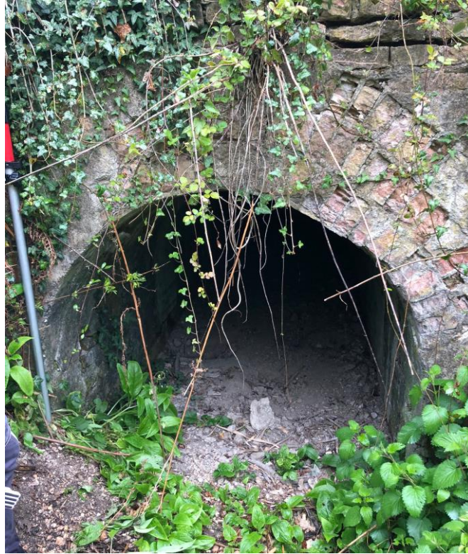
Figure 14 Opera 8 - Vista Nord
