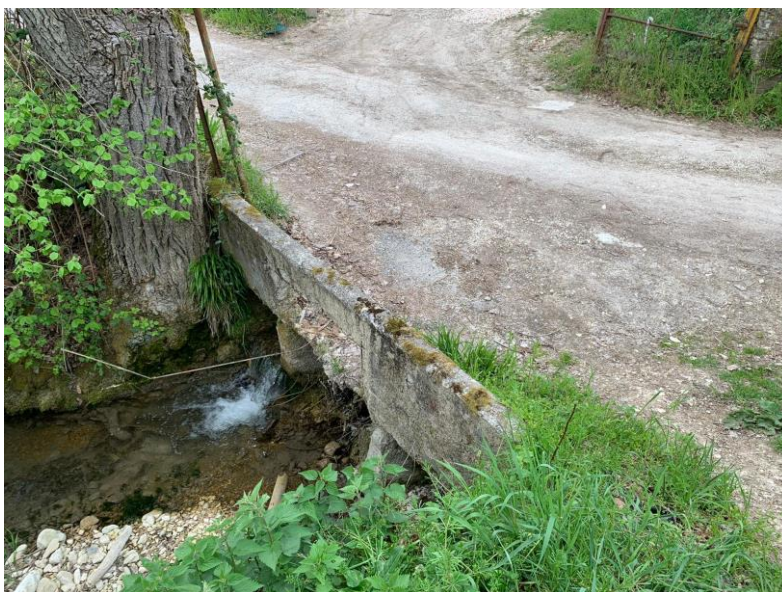
Figure 8 Scolo idraulico sottopassante la strada carrabile
