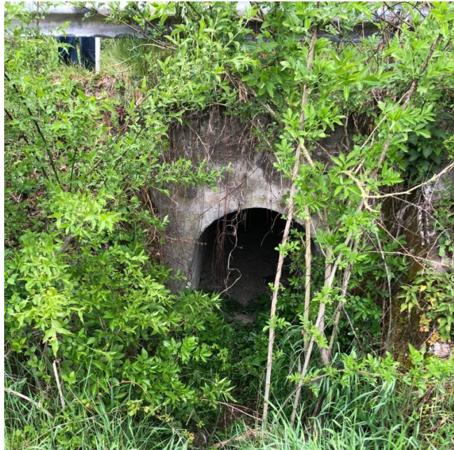
Figure 12 Opera 7 - Vista Nord
