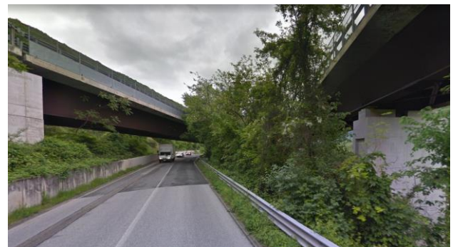
Figura 7-13: Tratto di viabilità locale tra i viadotti della SS76 a monte della stazione di Albacina
