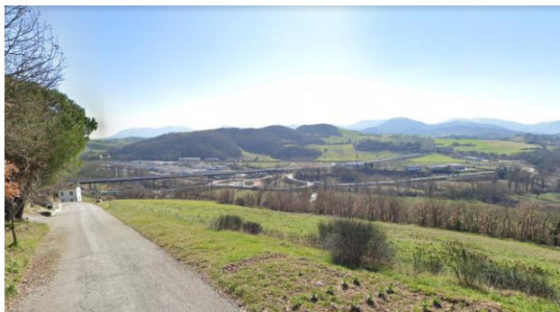
Figura 7-12: Vista del fondovalle dal versante settentrionale verso lo svincolo di raccordo tra viabilità locale ed SS76
