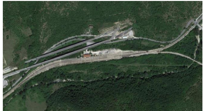
Figura 7-8: Coperture forestali nell'area dei versanti montano/collinari presso la Stazione di Albacina
