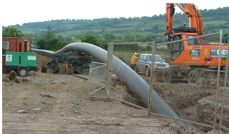
Figura 1-18 esempio di fase di perforazione e successivo inserimento di una tubazione in PEAD
