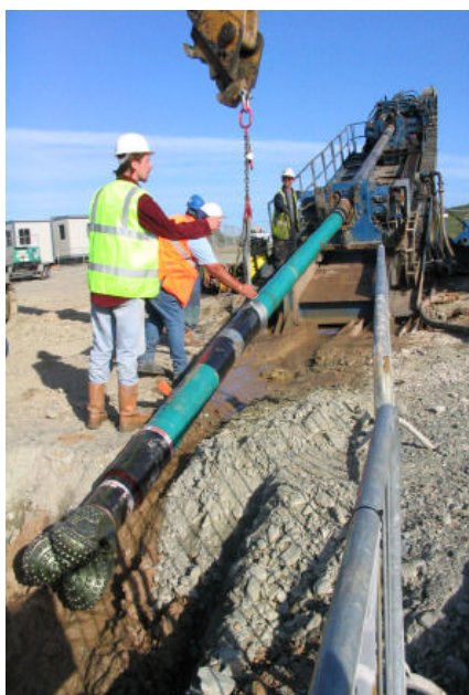
Figura 1-18 esempio di fase di perforazione e successivo inserimento di una tubazione in PEAD
