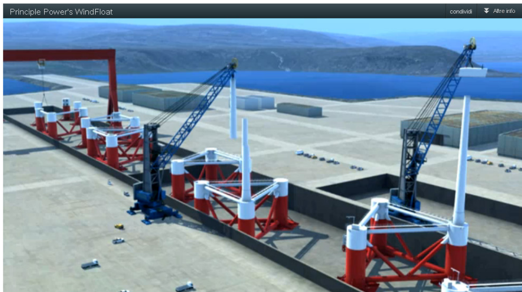
Figura 1-2 Innesto della torre sul tronchetto
