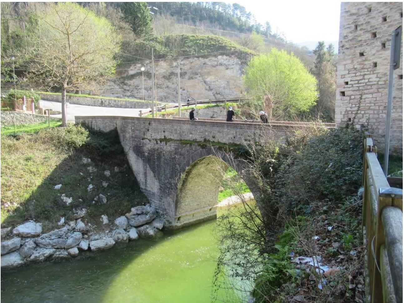
Fig. 19 – Genga, loc. San Vittore, il ponte romano sul fiume Sentino (P.A. 54).
